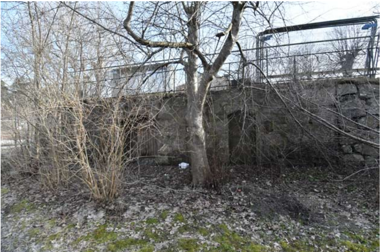
De igenmurade källardörrarna i terrassens nordöstra hörn. Notera även det gestaltade smidesräcket, sannolikt samtida med 1927 års ombyggnad.
