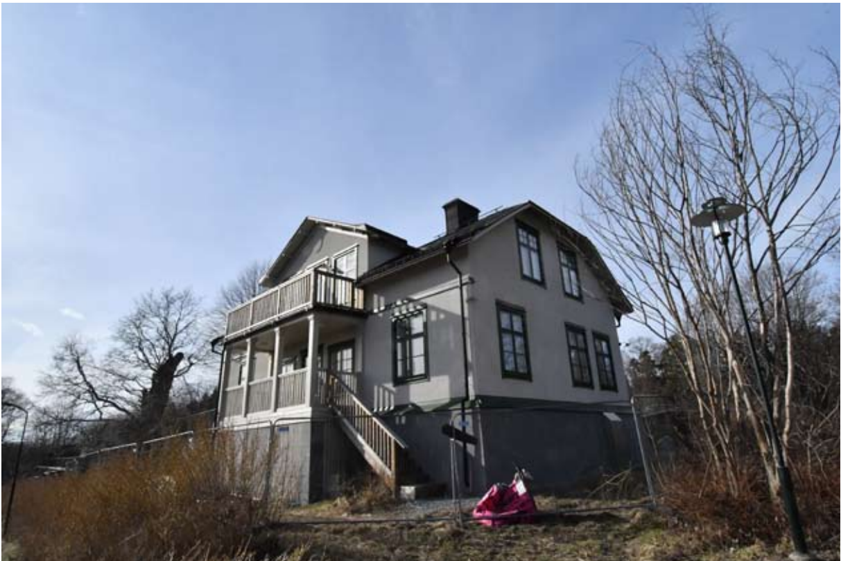
Villa Marieborg från sydost, från parkytan ned mot Magelungen. Tomten är inhägnad då arbeten pågick på fastigheten vid tillfället. Byggnaden har en karakteristisk volym med frontonen mot söder som motsvaras av en mittrisalit i norr.
