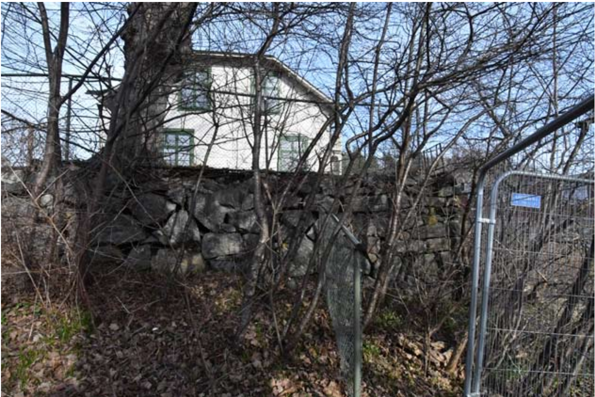
Terrassmuren från sydväst.
