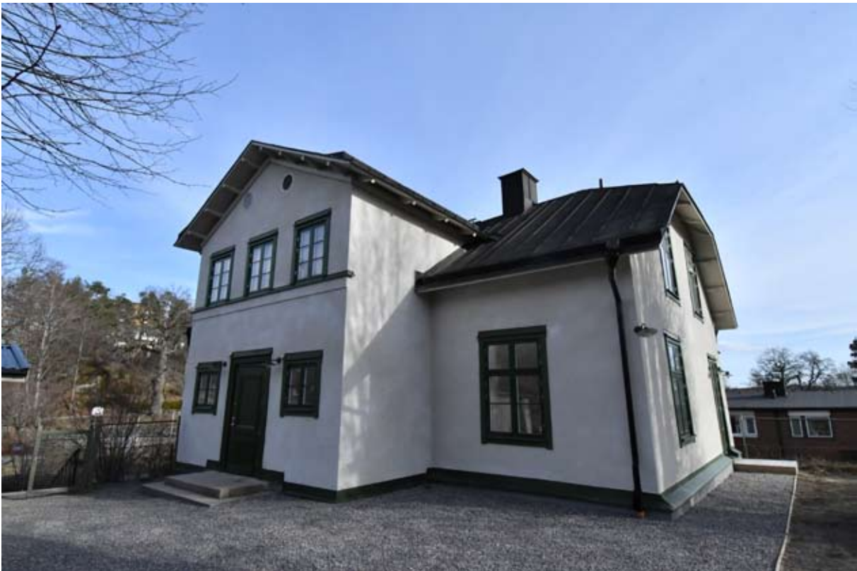
Huvudbyggnaden från nordväst. Byggnaden har nyligen renoverats i samband med en hussvampsanering.
