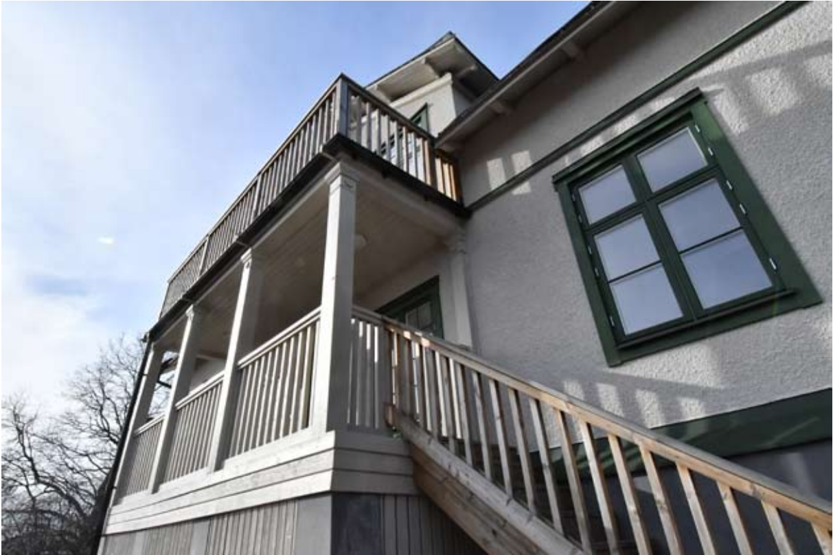
Altanerna på byggnadens södra fasad med kolonnimiterande stolpar. Räckena har ursprungligen haft en annan utformning, men ändrades under sent 1900-tal.
