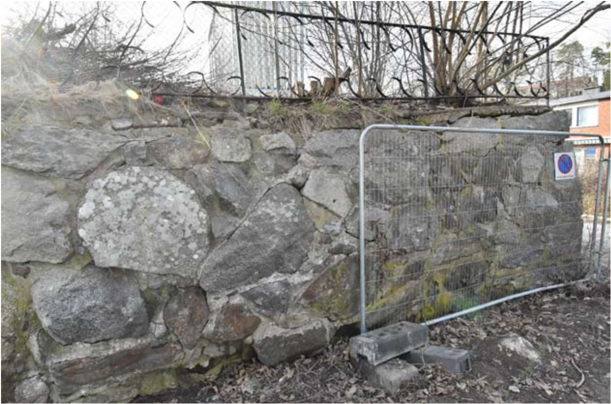
Detalj av terrassmuren och smidesstaketet i hörnet mot nordöst.
