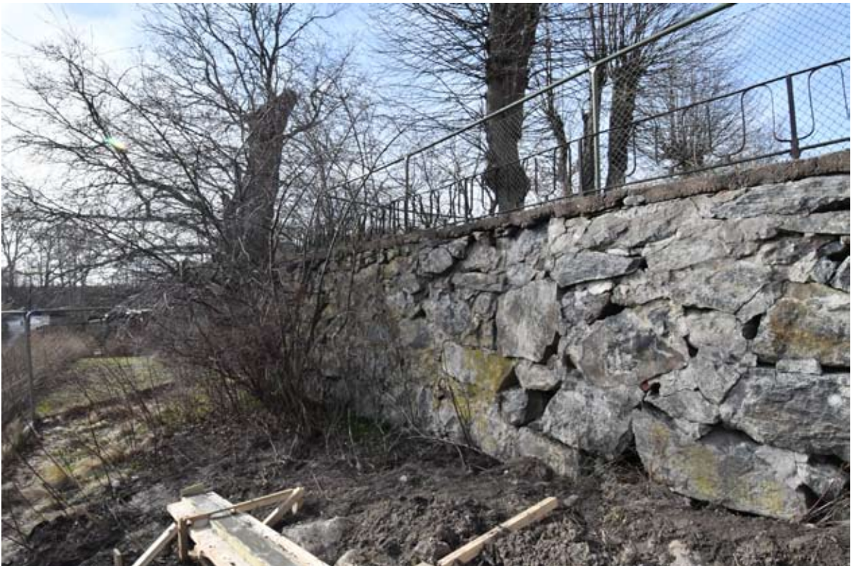
Terrassmuren i planområdets södra del. Smidesracket har här ett enklare utförande och är möjligtvis tillkommet senare än det mot norr.
