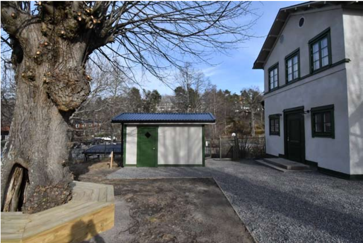
Planområdets östra del mot öst. Förrådsboden från 1990-talet har renoverats samtidigt som huvudbyggnaden.
