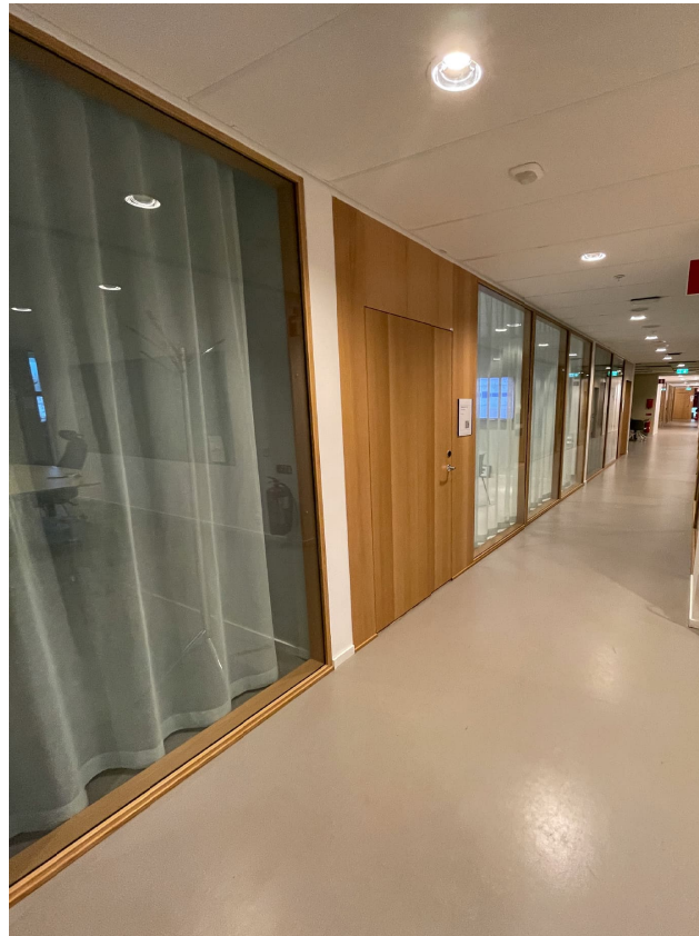
Korridorsystem med kontor med flyttbara systemväggar i glas och portal med tätt dörrblad. Denna lösning har i delar av kontorsutrymmena ersatt den ursprungliga.
