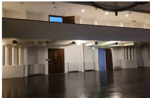
Längs den södra väggen i Vita Havet har flera ändringar gjorts i anpassningen för SIDA. Installationer har tillkommit, dörrar har bytts ut eller tillkommit och inklädnad av nischer har rivits.
