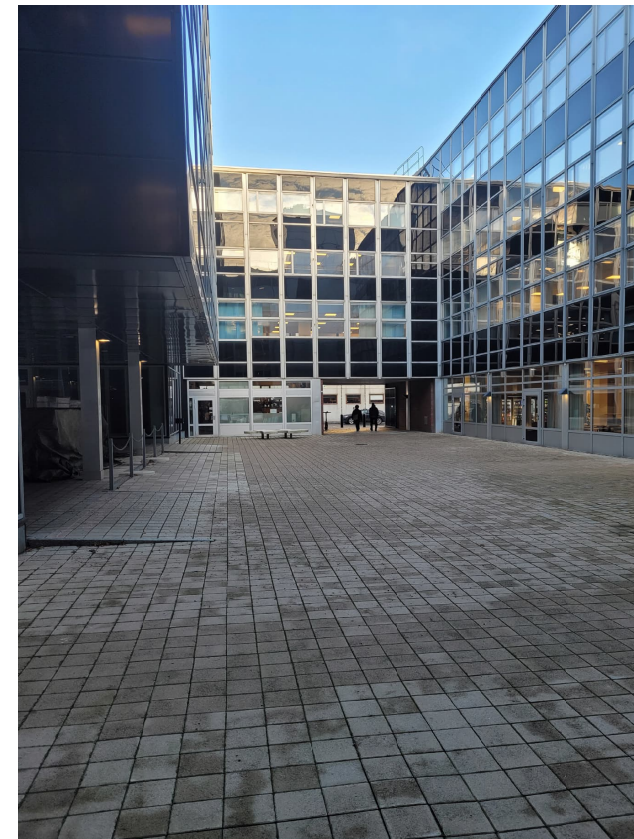
Norra gården med portik mot Borgvägen. Filmhuset anas på andra sidan vägen.
