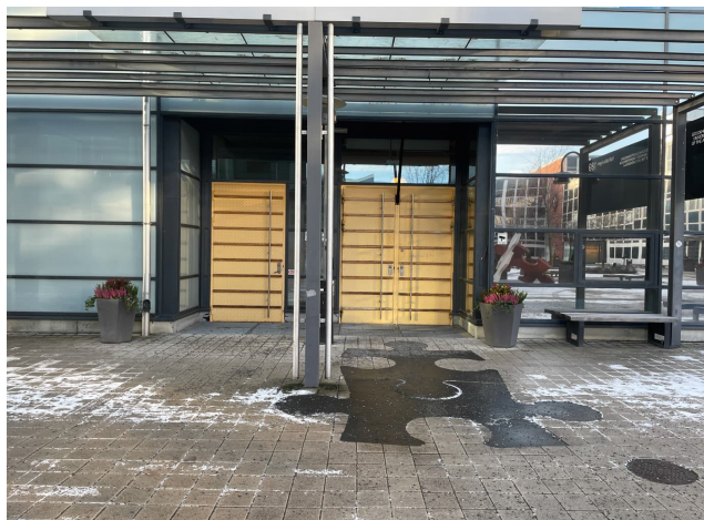
Huvudentre till Stockholms konstnärliga högskola, pussel markerar entrén och entrédörrar i räfflad aluminiumplåt.
