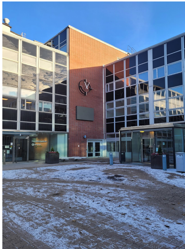
Fasad delar av hus B, A och D, från centrala gården. I mötet av volymerna vid Konstfacks huvudentré återfinns ett ursprungligt fasadur. Entréerna förnyades med tillbyggnader 2004-08.
