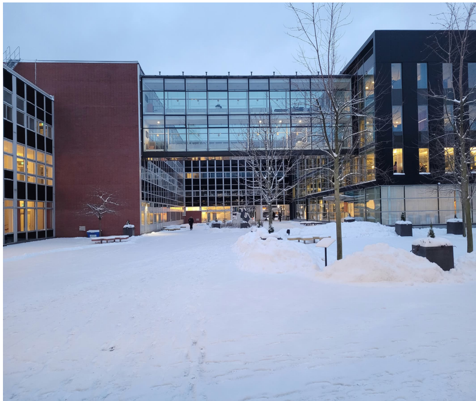
Fasad förbindelsegång mellan hus E och O samt delar av hus D, E, N och O, från centrala gården.
