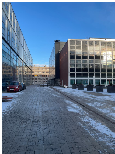
Fasad delar av hus B och J, från innergården, i mitten av bilden skymtas Filmhuset och till vänster i bild Dramatiska institutet numera Stockholms konstnärliga högskola (Tre Vapen 7).
