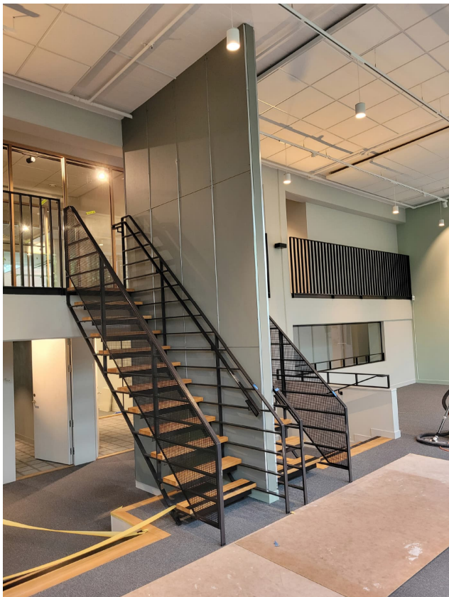
I hus F har f.d. skulpturateljéer hyresgästanpassats under 2023. För att tillgodose krav på fallskydd och tillgänglighet har trapporna försetts med kompletterande nät och extra handledare. Entrésol-räckena har byggts om så att de har vertikal istället för horisontell indelning.
