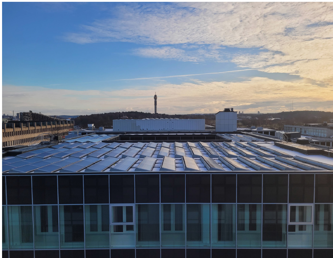
Taklandskapet över hus J, sett från Tre Vapen 7. Solpaneler har monterats på stora delar av taktorna.
