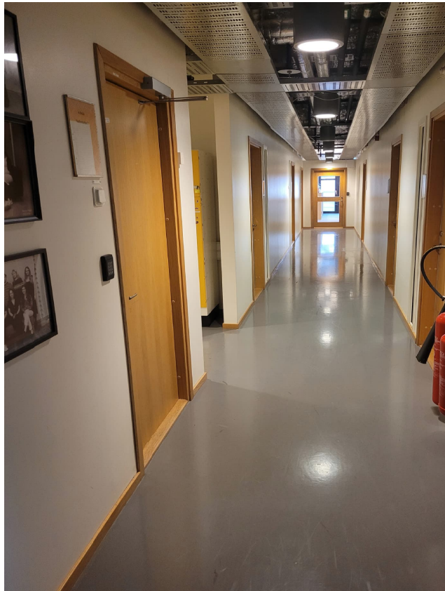
Exempel på ursprungligt korridorsystem i kontor med karm och tätt dörrblad.
