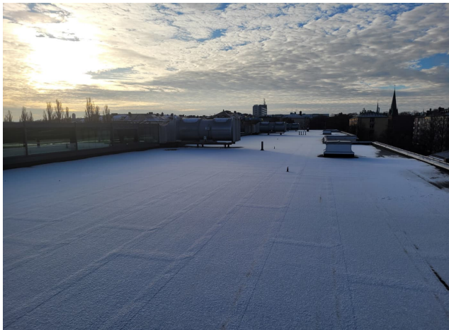
Byggnadens yttertak är med undantag från lanterninen till största delen slätt och papptäckt.
