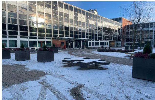
Fasad delar av hus B, A och D från centrala gården. I stora delar av bottenvåningen i Hus B har ursprungliga aluminiumpartier bytts ut mot nya med grövre dimensioner.
