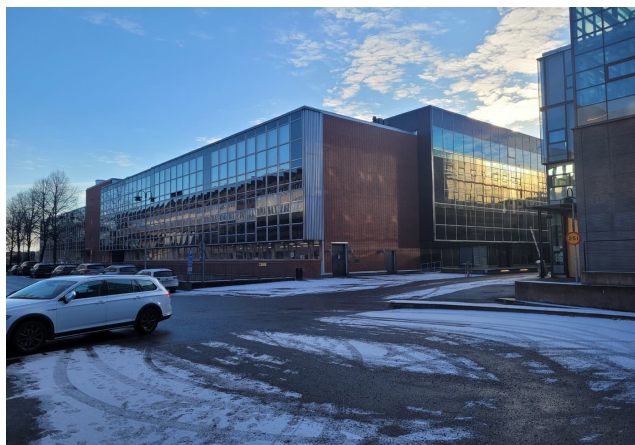
Fasad delar av hus C och J, från Borgvägen.
