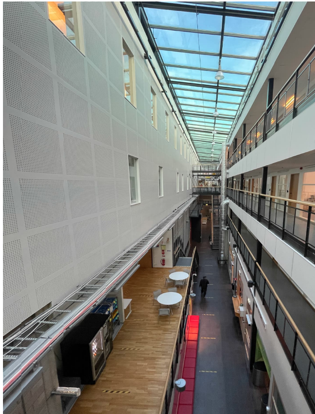
Atriet med loftgångslösning och väggar med akustikdämpning.
