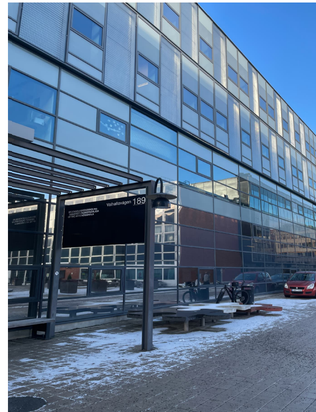
Fasaden mot gården och gångstråket mot Filmhuset. Volymen är utpräglad enkel. Stora delar av fasaderna består av icke genomsiktligt glas.
