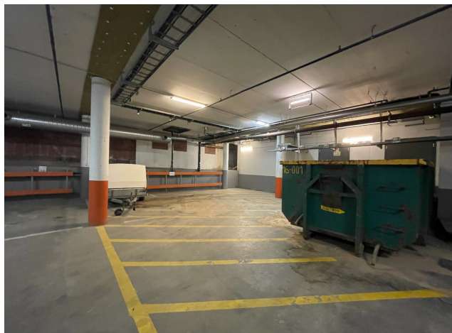
Logistikytor i källarvåningen.
