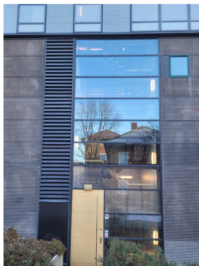
Trapphusen är genomgående uppglasade.
