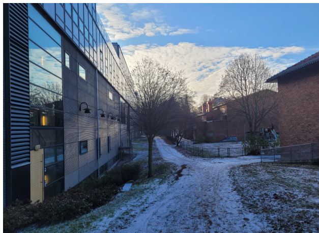
Fasaden mot väster är sluten och har utrymningsdörrar mot ett gångstråk som delar av campusområdet från Gärdesskolan.
