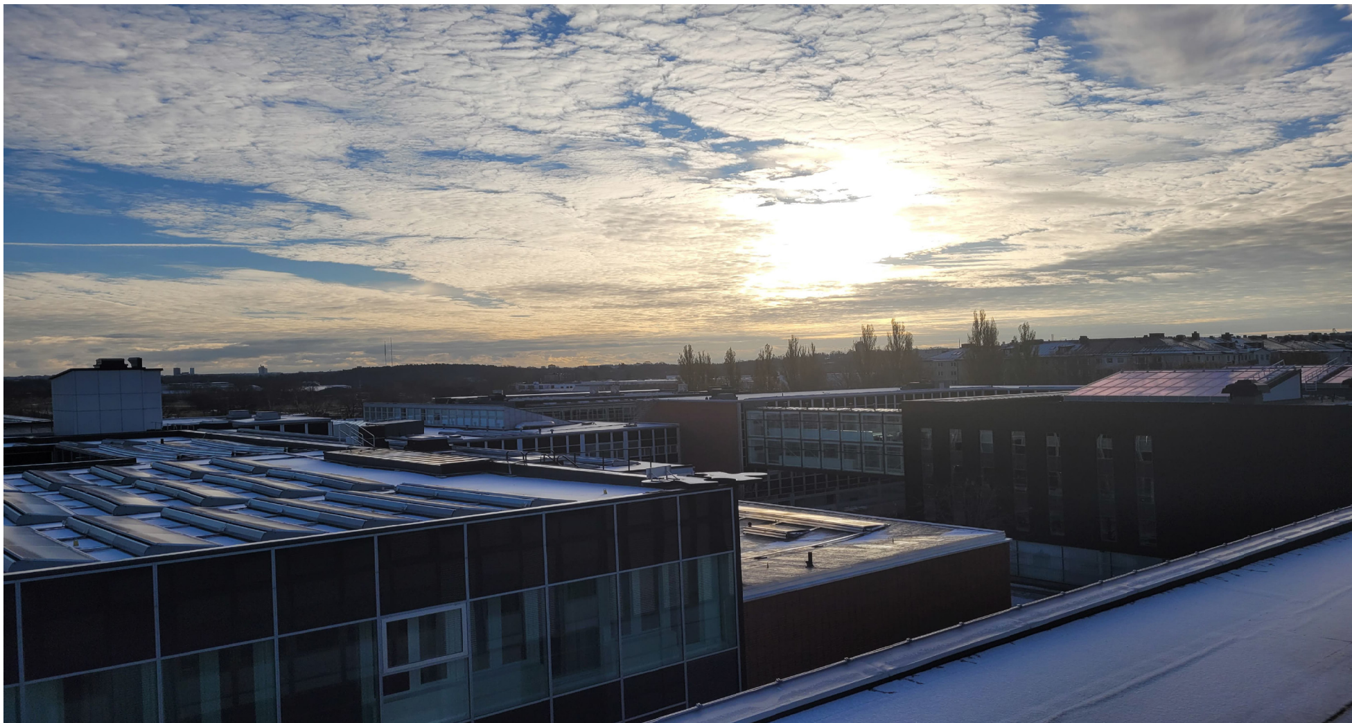
Taklandskapet i Tre Vapen 2. Närmast i bild hus J, till höger i bild hus O, foto taget från taket på Tre Vapen 7.
