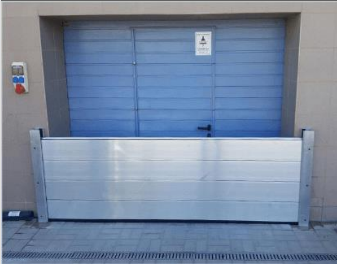
Figur 10.3 Exempelbild översvämningsskydd för byggnader. Källa: Hydratec
