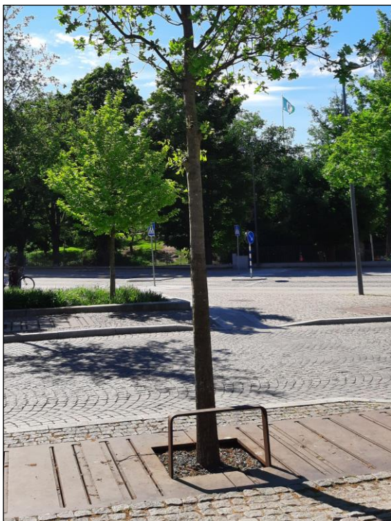
Figur 9.1 Trädplantering i skelettjord, med en mindre öppning för vatten att rinna ner. Foto: NIRAS Sweden.
