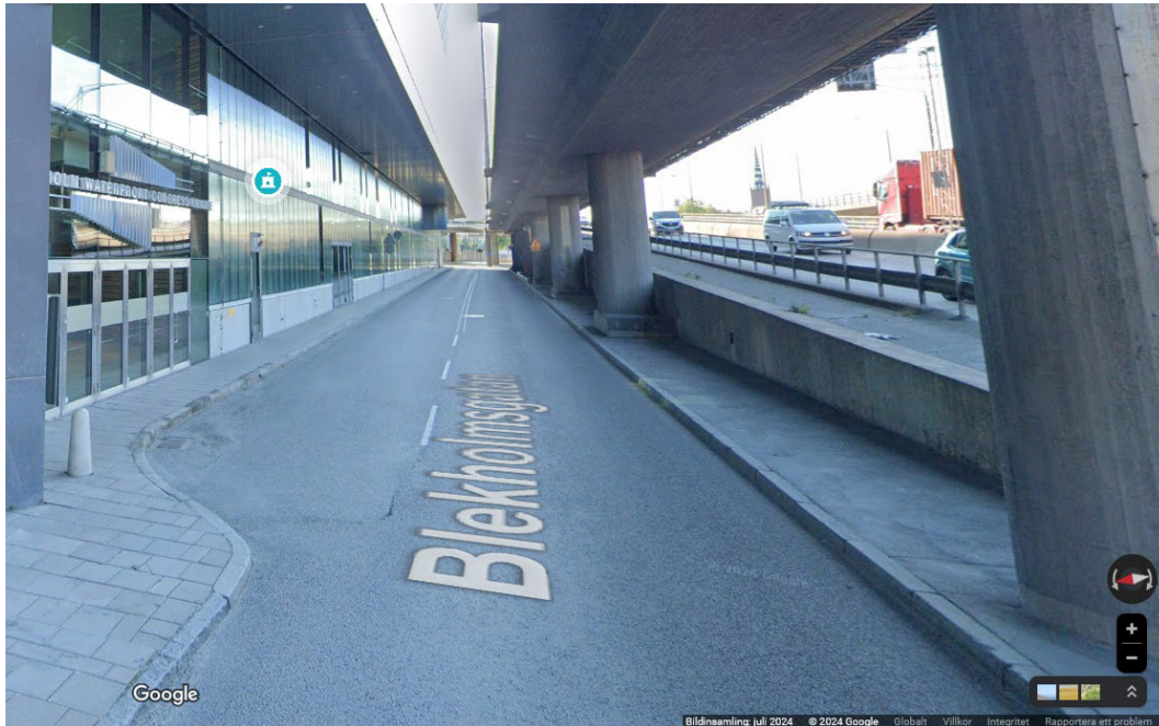
Figur 11. Blekholmsgatan från nordväst med skyddszon vid utrymning. Stockholm Waterfronts fasad syns till vänster i bild och nuvarande ramp mellan Centralbron och Klarastrandsleden till höger. Bildkälla: Google.
