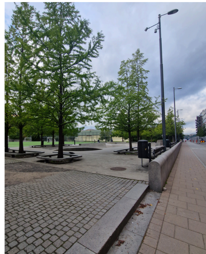
Mur mot Elersvägen, sett från infart vid Pumphus mot skejtyta. Tennishallen i bakgrunden.
