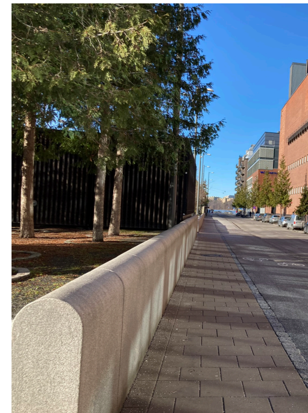
Mur längs Elersvägen från entreplatsen och pumphuset.
