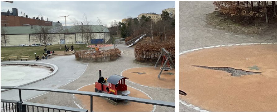
Lekytor med ovalt- och cirkulärt formspråk. Gummiasfaltsytorna har slitits och är i behov av upprustning.
