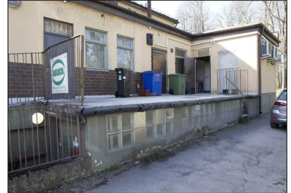
I lastkajens sockel finns ingjutet betongglas.
