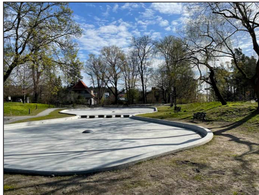
Vy över Svandammen mot öster, i mitten av dammen finns sex trampstenar. Dammen har en ljus betongbotten.
