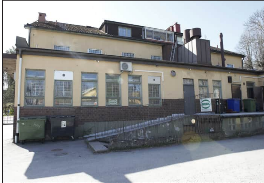
Fasaden mot norr har ett brokigt inslag. Taket består av flera uppstickande byggnadsdelar så som ventilationshuvar, skorstenar, rökluckor med mera. Takkupan har ett mindre utstickande fönsterparti i aluminium. På fasaden finns flera olika luftvärmepumpar. Längst med fasad står sopkärl.
