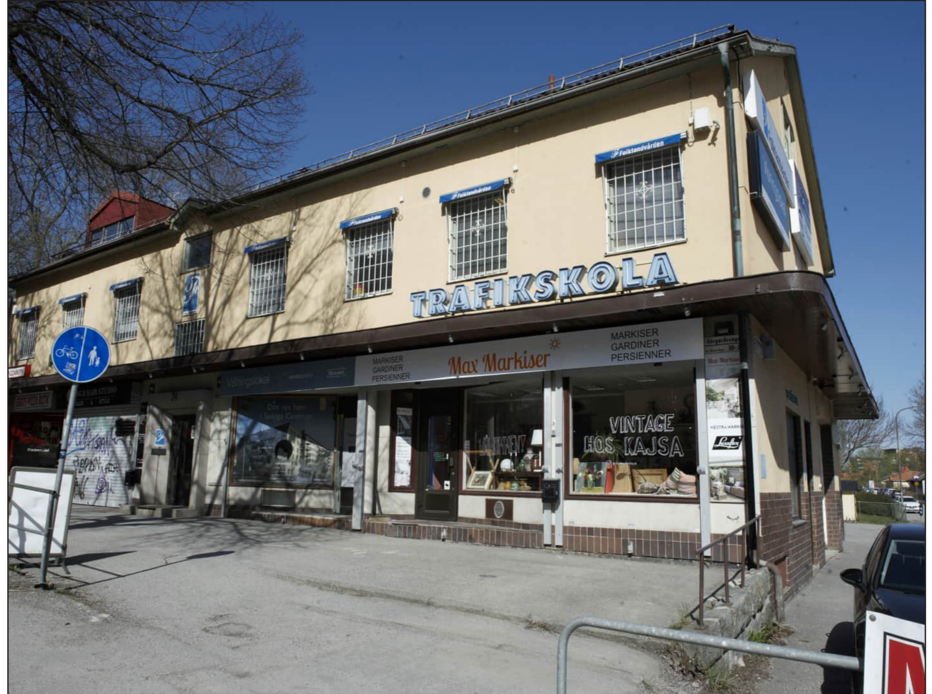
Butikslängan skärmtak. De bruna klinkerplattorna fortsätter på gavelfasaden mot öster.
