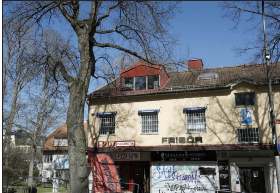
Övervåningens fönster är enluft och försedda med vitt galler. På taket finns en takkupa inklädd i röd plåt. Fönstren i takkupan är av enluft.
