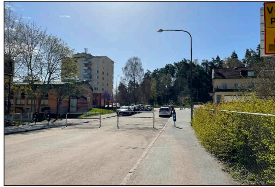
Värstasgårdsvägen från norr med byggnaden inom Värsta gård synlig till höger, till vänster syns församlingshuset och högden i Gisle 8, rakt fram impedimentet utefter södra sidan av Sörgårdsvägen.
