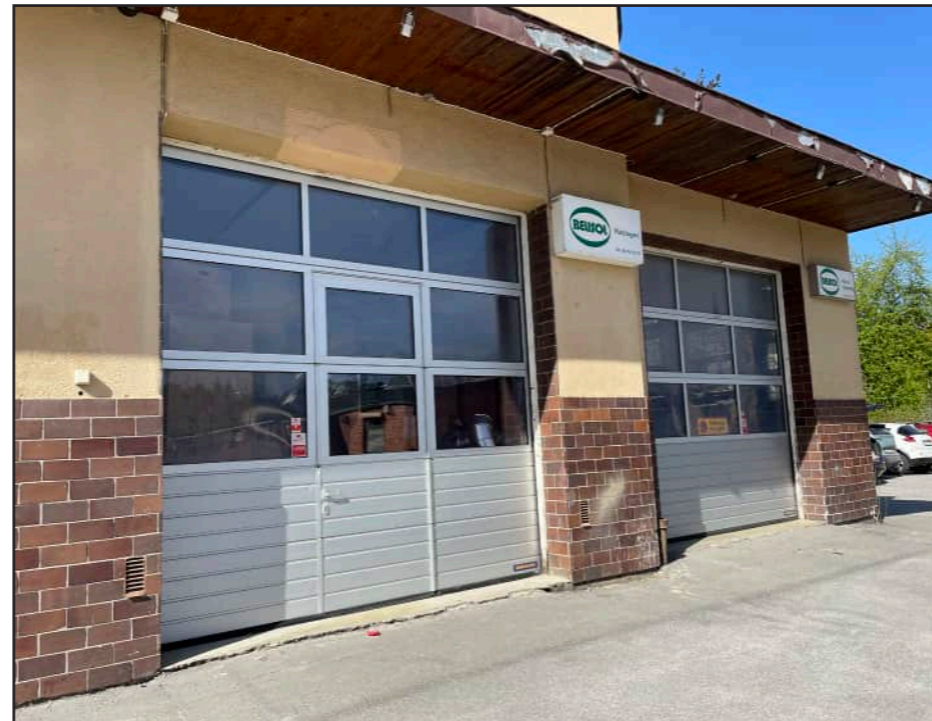
De bruna klinkerplattorna återfinns i delar av garageportarnas dörrnisch. Garageportarna är uppglasade och i aluminium. En av portarna har en öppningsbar dörr.
