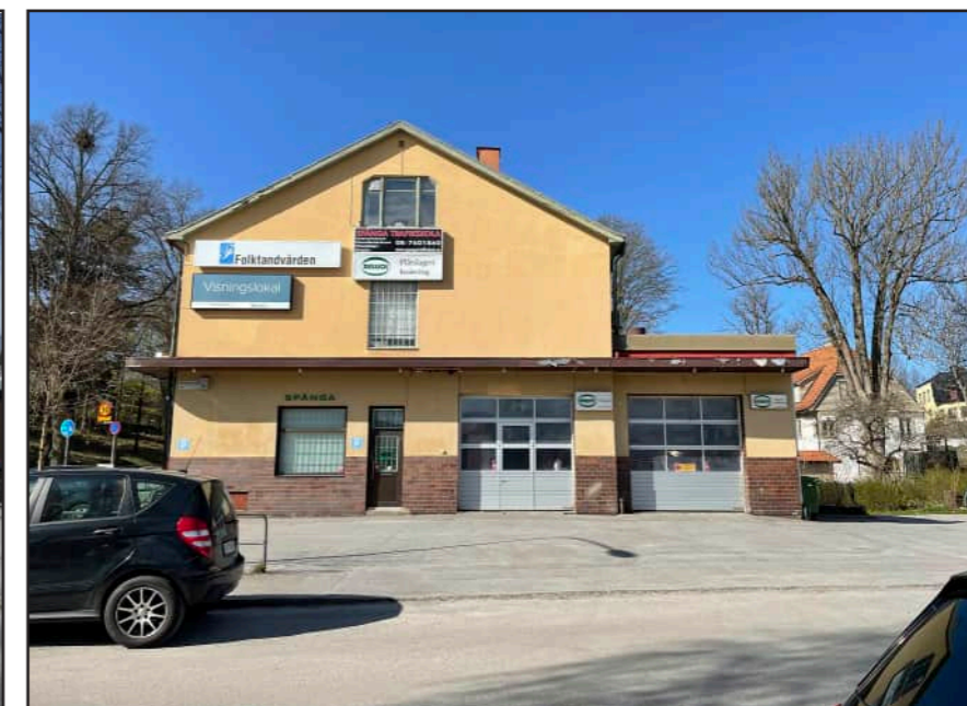
Fasad öst mot Värstagsvägen. Här låg tidigare bensinmack, enkeldörren ledde in till mackens butik, till höger två verkstadsportar.
