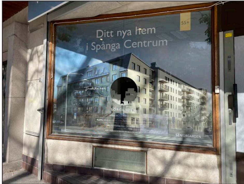
Skyltfönster och källarfönster av trä.
