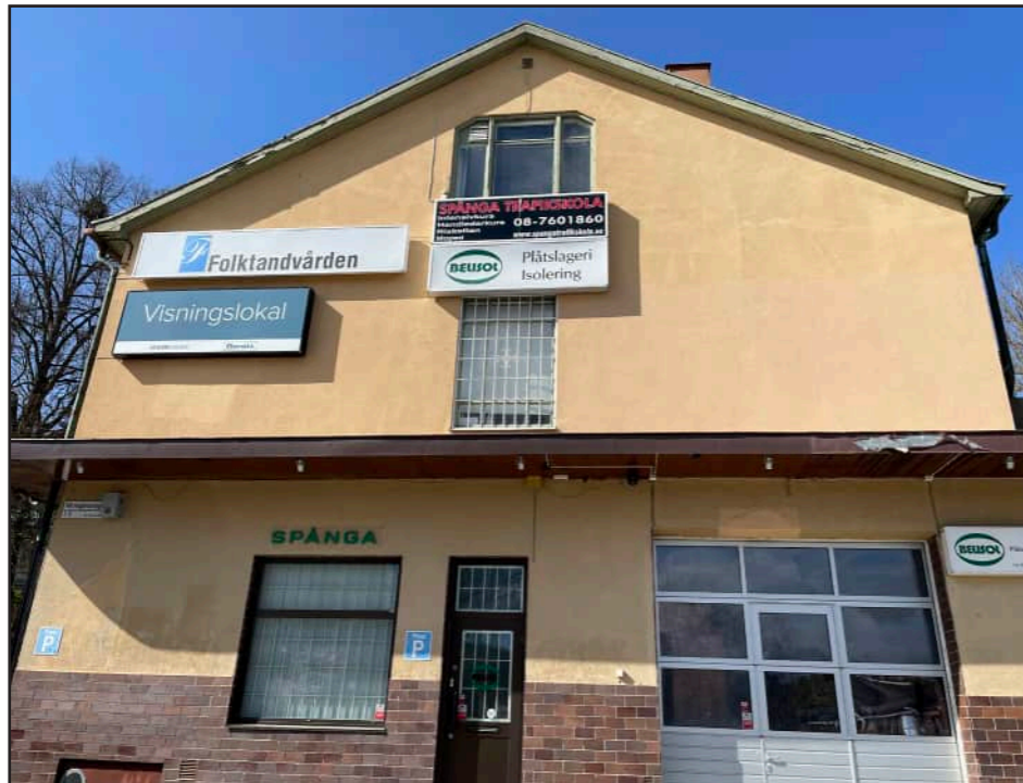
Byggnadens takfot är inklädd och sticker blygsamt ut över fasaden. Gavelfasaden mot öst har en varierad fönstersättning i olika utföranden. Under taknocken finns ett trelufts-fönster med snedskurna hörn.
