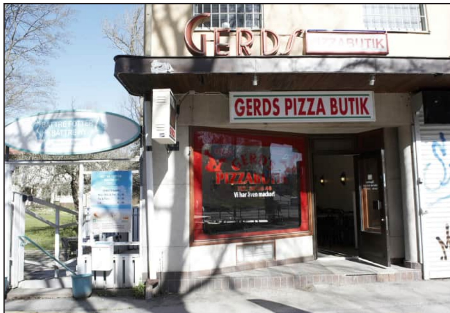
Entréparti till butikslokal. Skyltfönster i brun kulör med en glasad aluminiumdörr i en mörkbrun kulör. Sockelns bruna klinkerplattor har placerats i det asymmetriska trappsteget och framför butiksdörren har klinkerplattorna ersatts med slät betong.
