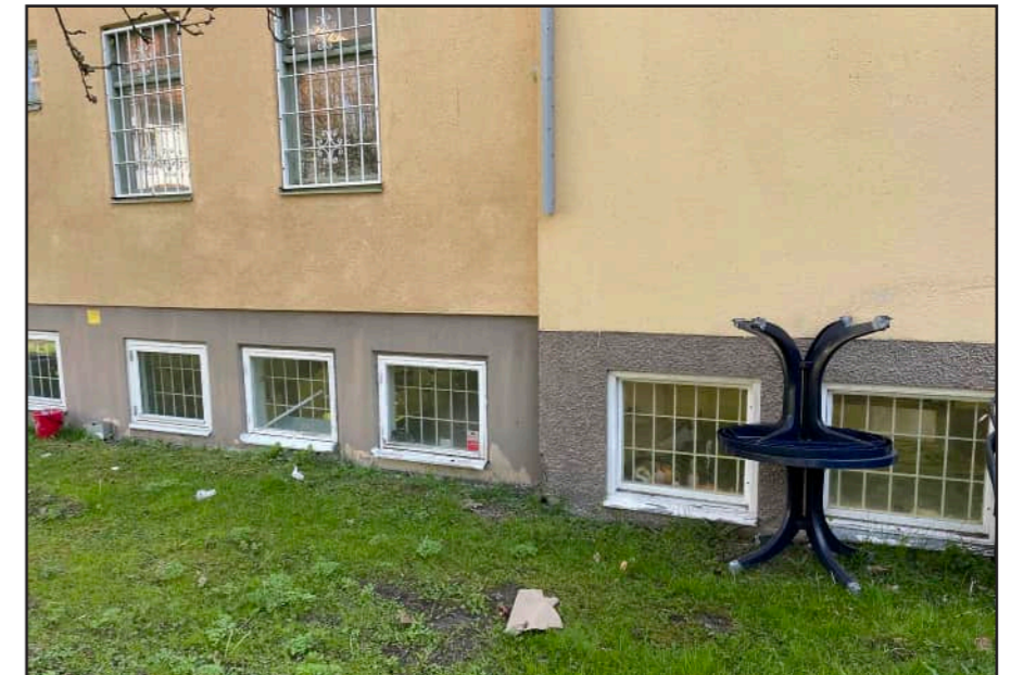
Mötet mellan den högre byggnadsvolymen till vänster och tillbyggnaden till höger. Sockel till höger är spritputs i en gråbrun kulör och till vänster är sockeln av målad betong. Tillbyggnadens fönster är enluft med spröjs och vitt utanpåliggande gallerfönster. Källarfönster är enluft med påliggande vitt galler.
