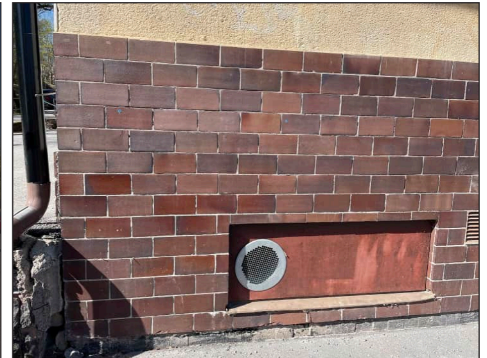
Mötet mellan den gula putsade fasaden och de bruna klinkerplattorna. Till vänster i bild, syns byggnadens nivåskillnad mellan butikslokalerna och garagedelen.
