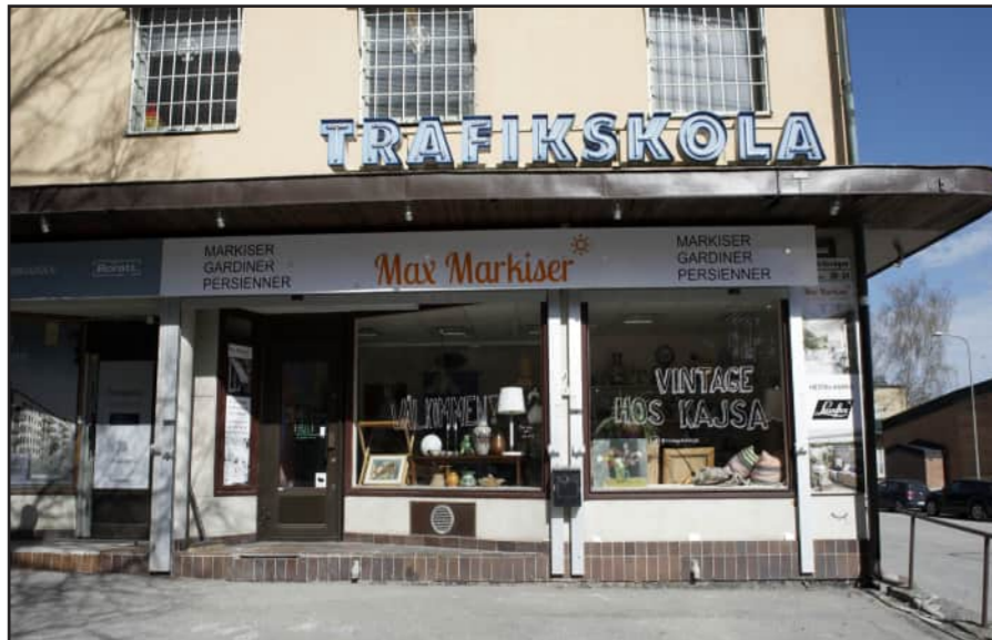
Entréparti till butikslokal. Skyltfönster i brun kulör med en glasad aluminiumdörr i mörkbrun kulör. Sockelns bruna klinkerplattor har placerats i det asymmetriska trappsteget.
