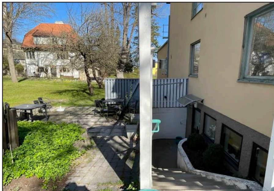
Källarnedgång längst den västra fasaden.
