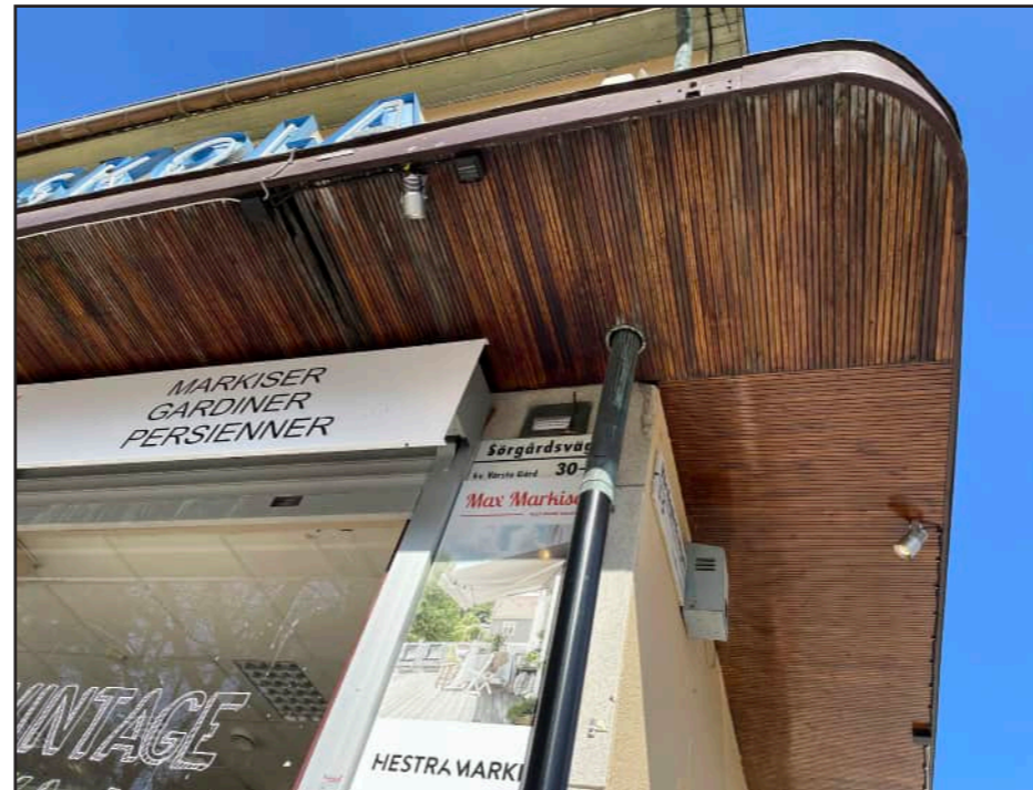
Skärmtaketets undertak är ribblagt trätak, så kallad karrosseripanel, som i hörn följer den lätt svängda böjningen. Ny panel har tillkommit där taket tidigare var sammanlänkat med skärmtaket över de tidigare bensinpumparna.
