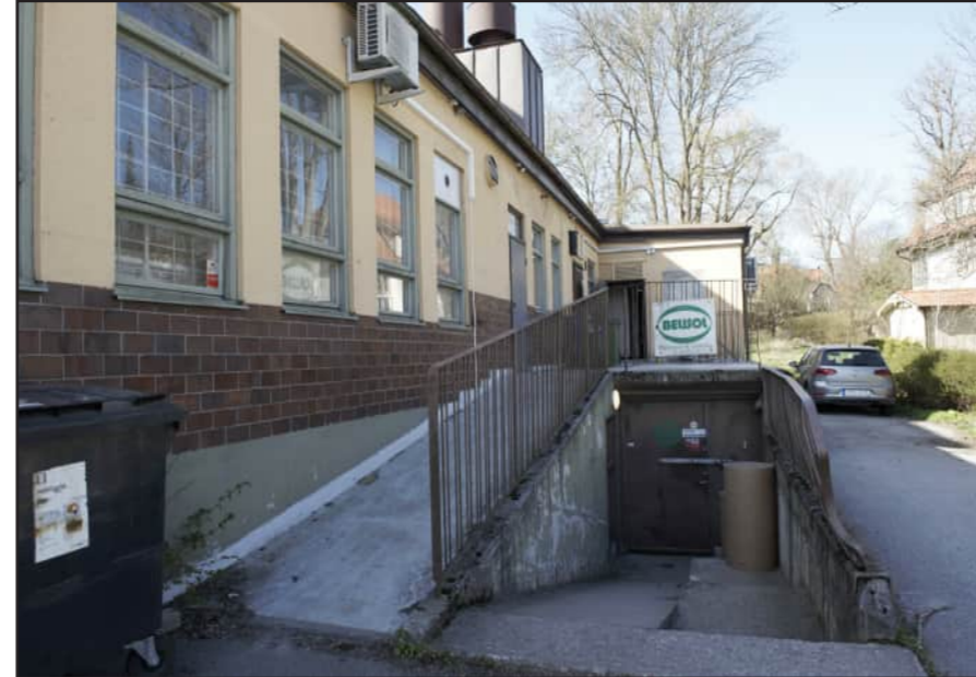
Lastkaj, ramp och källarnedfart längst med byggnadens norra fasad. Längst ramp er finns smidesräcke.
