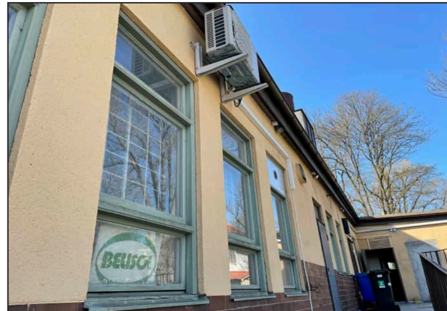
Enluftsfönster i en ljusgrön kulör med spröjs samt invändig vitt galler i fönstret mittendel.
