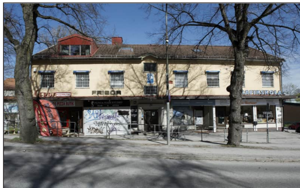
Fasad söder mot Sörgårdsvägen, i bottenvåningen finns en butikslänga med fyra butikskloaker.
