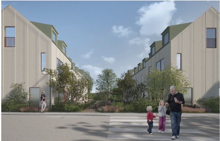
Vy från väster, från Stora Kvinns väg mot Långbroparken. Bilden visar möjlig utformning av ny bebyggelse inom ramen för vad detaljplanen medger. Bild: Konzept
