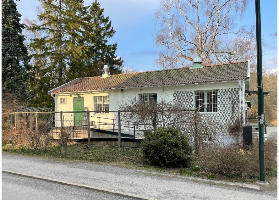
Det före detta trädgårdsmästeriet på fastigheten Lågbron 1.
