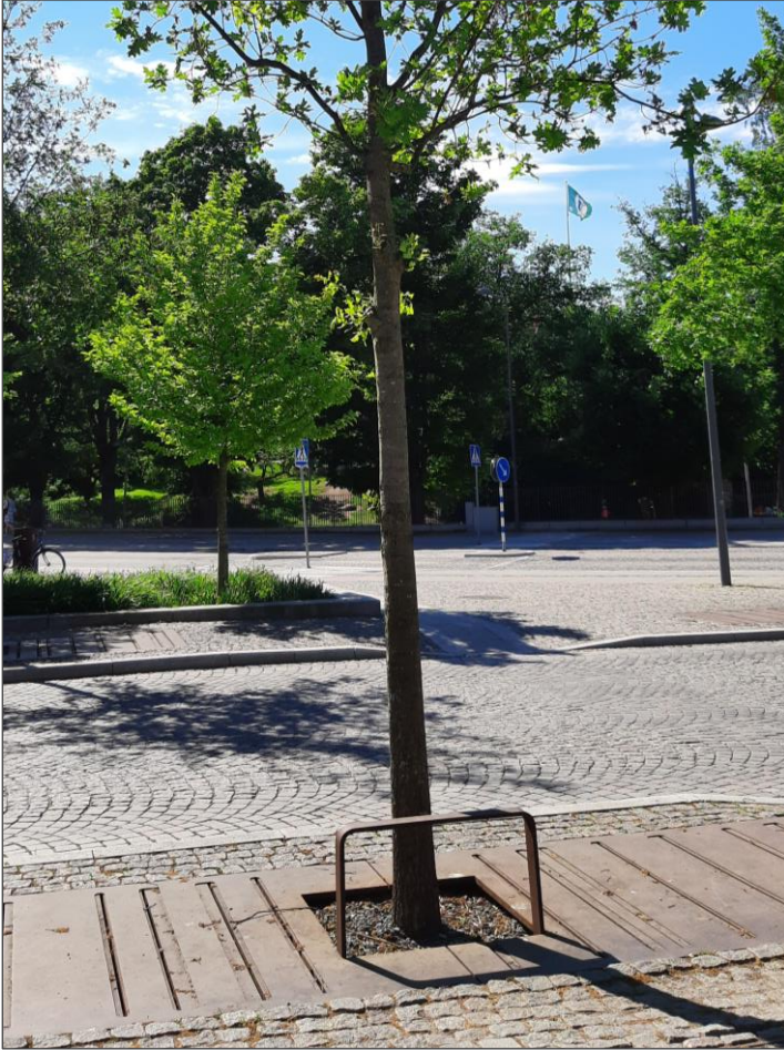
Figur 8.5. Trädplantering i skelettjord, med en mindre öppning för vatten att rinna ner. Källa: NIRAS
