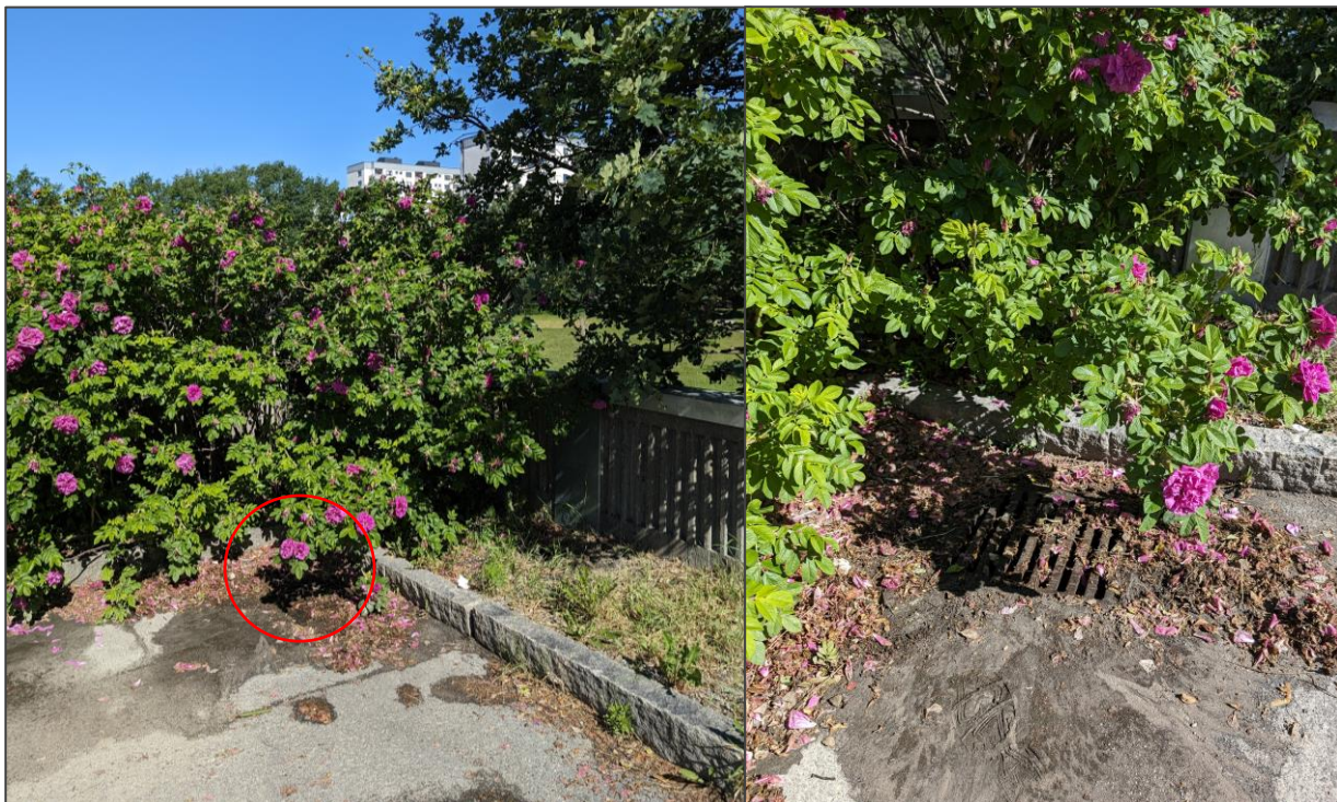
Figur 5.4. Dagvattenbrunnen ligger i parkeringens nordvästra hörn. Den är enligt fastighetsägaren underdimensionerad och under platsbesök 2024-06-12 var den täckt med löv från intilliggande vresrosbuske.
