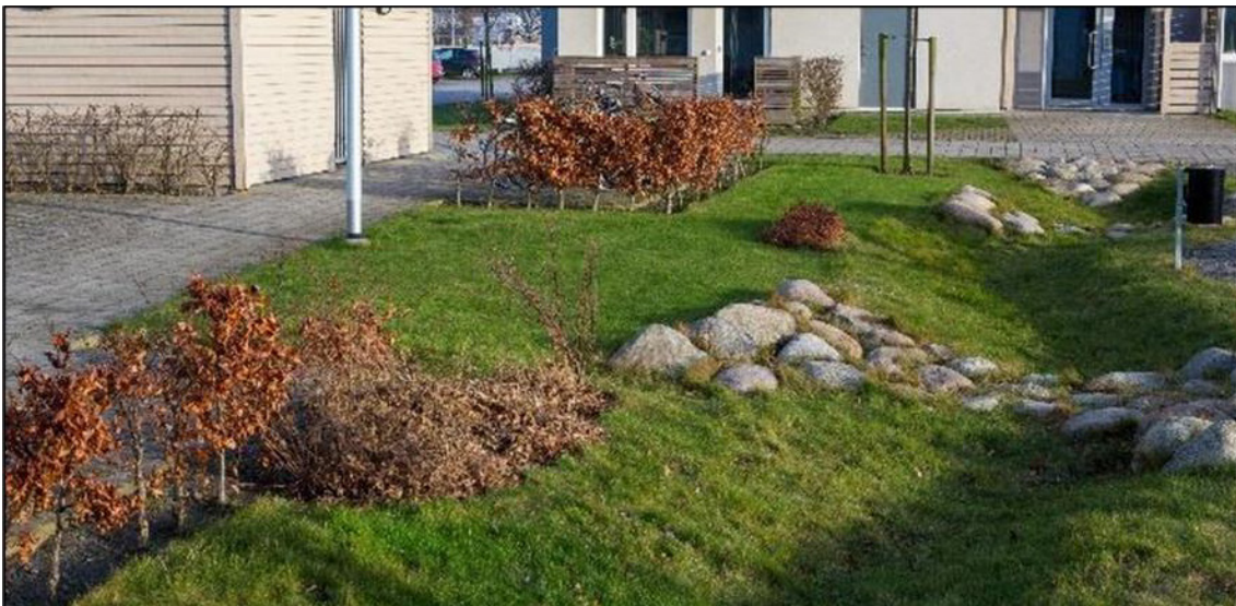
Figur 8-6. Exempel på gestaltning av infiltrationsstråk inom gårdsmark, där stenar fungerar som dämmen för att skapa trögare avledning av dagvatten.
