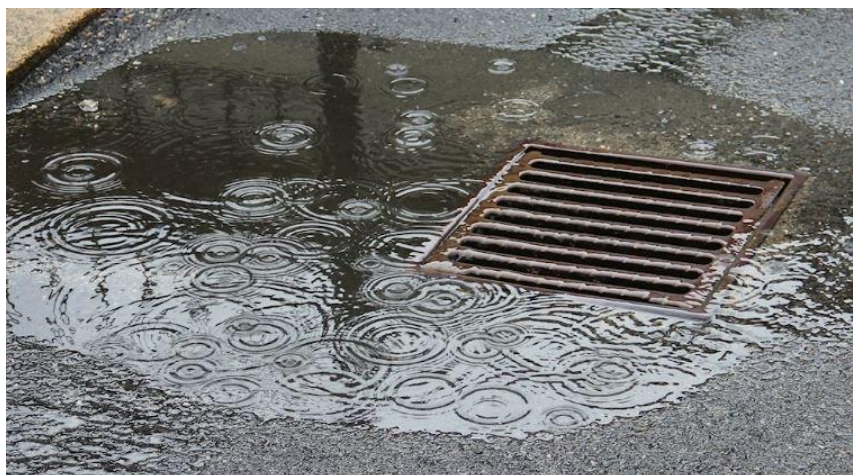
Figur 21 exempelbild på dagvattenbrunn med gallerbetäckning.
