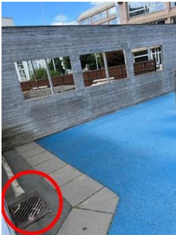
Figur 10 Befintlig brunn inom skolgården tillhörande Heliosgatan 22.
