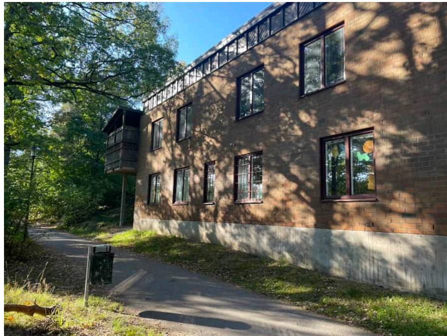
Fasad mot öster med balkongkonstruktionen på södra sidan.
