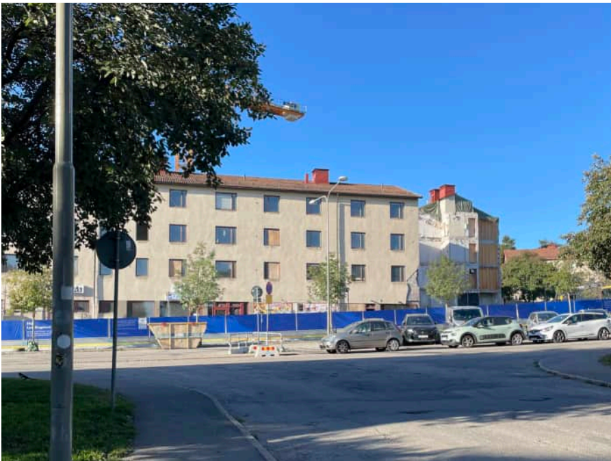
Lamellhusområdet vid Lysviksgatan genomgår en upprustning och förtätning. Här sett från Färnebogatan.
