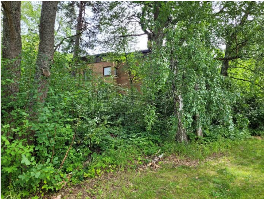
Munsö 1 från gångstråk inom Farstaäng. Från många punkter i omgivningen upplevs förskolebyggnaden dold och undanskymd, sannolikt på ett sätt som stämmer med intentionerna på 1970-talet.
