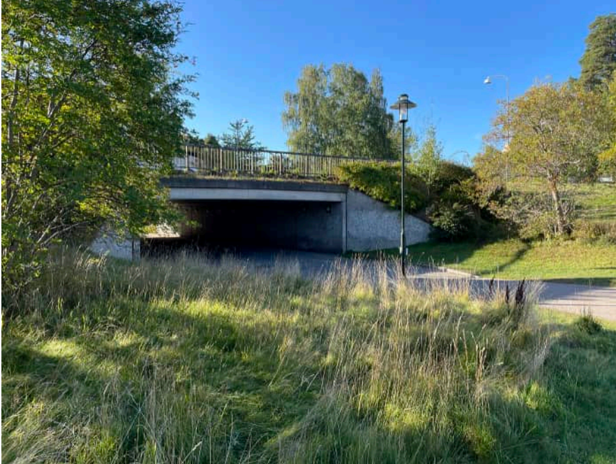
Gångunnel under Farstavägen i norr, en av entréerna till parken.
