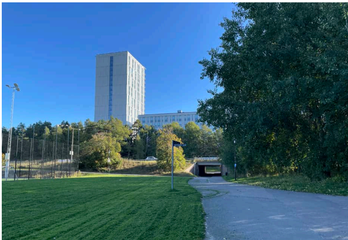
Utblick från Farstaäng mot Nynäsvägen. Här har ett nytt punkthus med sjutton våningar och ett lamellhus i fem våningar vid Ekebergabacken inom kv. Ekberga skapat en ny visuell inramning.
