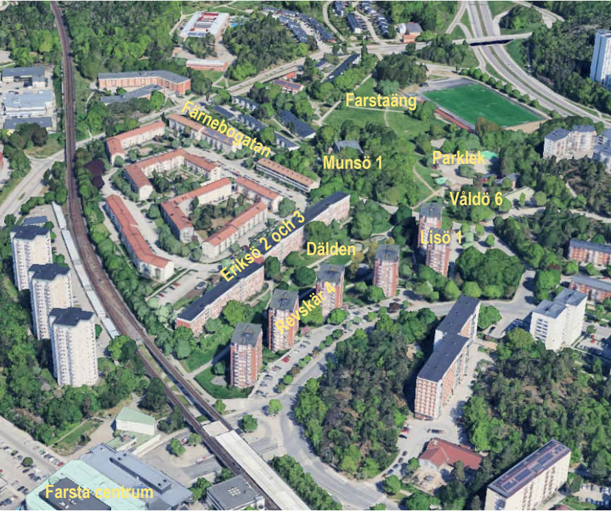
Flygbild över Farsta. Google Earth, med senare markeringar av Tyréns.
