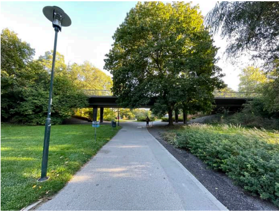
Viadukt under Färnebogatån som leder ut mot Farstaäng.
