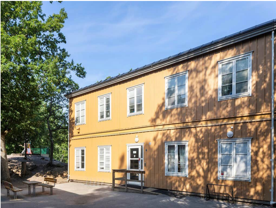
Fasad mot sydöst. Nordiqus.
