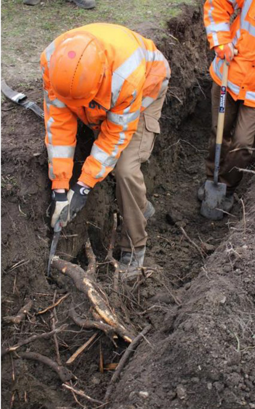
Bild 4. Trädrötter som måste avlägsnas vid schakt beskärs med beskärningsverktyg (handsåg).
