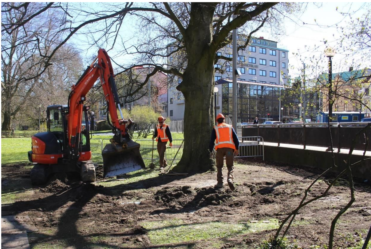
Bild 9. Avtagning av grässvål vid utförande av markvitalisering.
