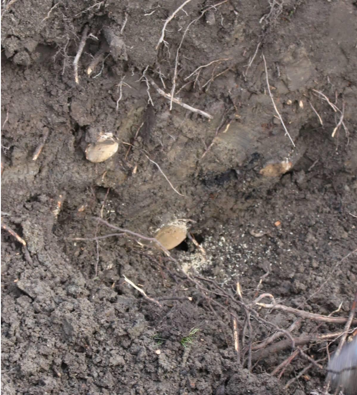
Bild 5. Korrekt beskurna rötter vid schakt.
