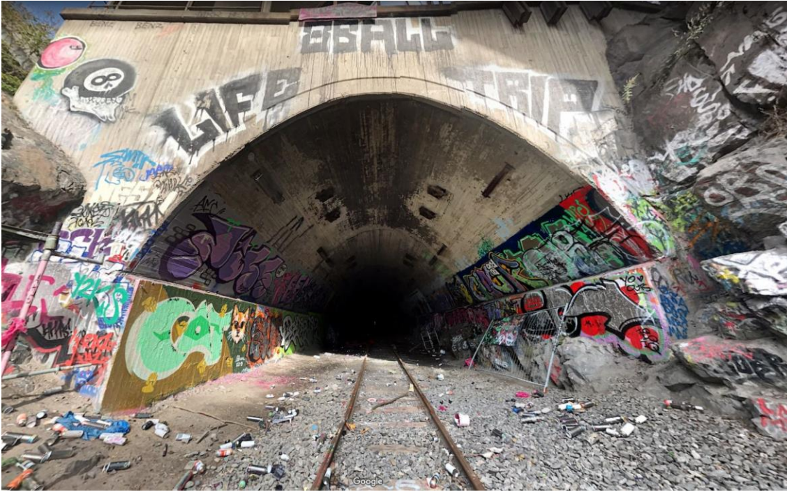
Figur 7 Den östra Nybodatunneln sedd från söder. Källa Google Maps
