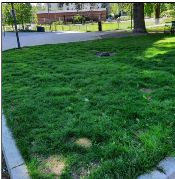
Figur 8.5 Grönyta i Norra Djurgårdsstaden, med bräddavlopp i form av kupolbrunn i mitten. Foto: NIRAS
