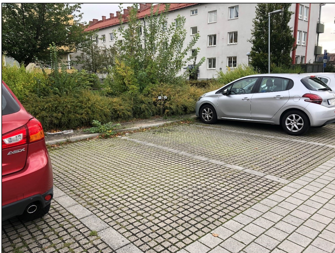
Figur 16. Exempel på genomsläpplig beläggning, gräsarmering (Foto: Bjerking AB).
