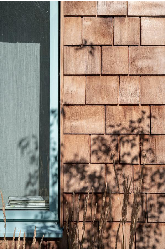
CEDERTRÄSPÅN, SMALA FÖNSTERKARMAR
