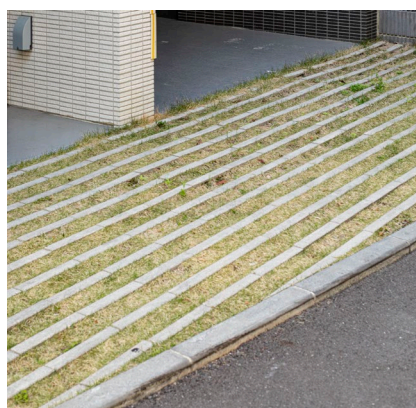
Exempel genomsläpplig beläggning i Tokyo. Foto: Oskar Forsblom
