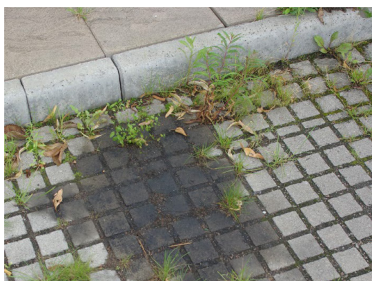
Oljespill som binds i beläggning och övre marklager kommer så småningom att brytas ner. Stockholmvatten och avlopp. Foto WRS
