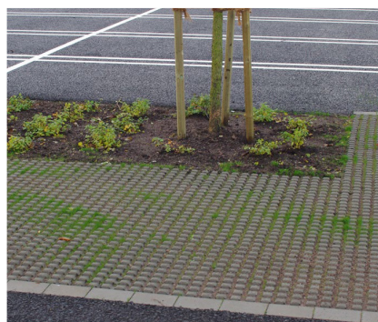
Exempel genomsläpplig beläggning. Stockholmvatten och avlopp. Foto WRS
