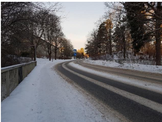
Figur 4. Färnebogatan intill planerad bostadsbebyggelse (höger i bild).
