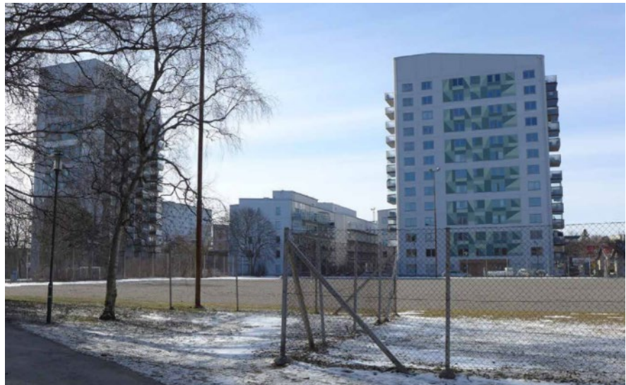
Foto som visar senare tillägg av byggnader i Högdalen centrum sett från fotbollsplanen norr om centrum.
