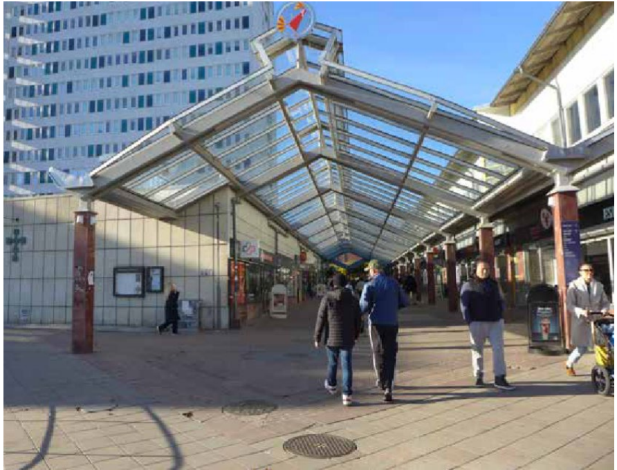
Befintligt skärmtak i Högdalsgången.
