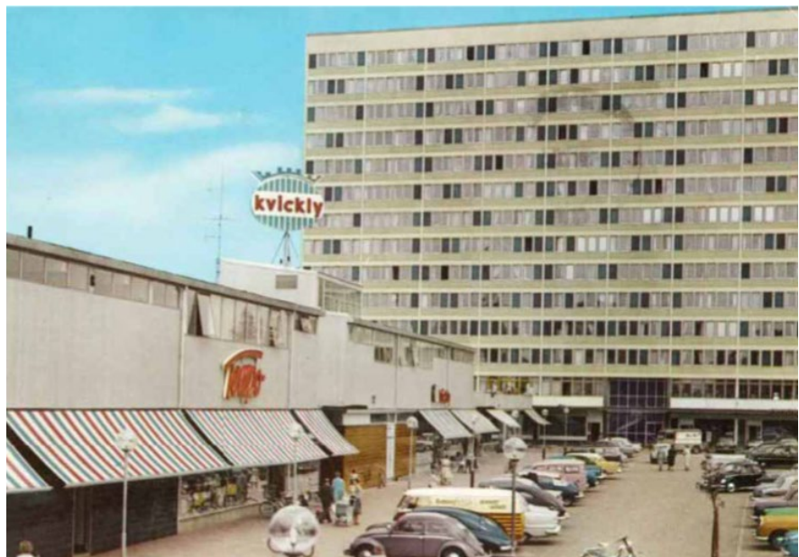
En äldre bild på befintlig bebyggelse (Imröret 10 och 7 och Skivhuset) vid Önskehemsplan. Bilden visar hur byggnaderna tidigare hade uppglasade centrumlokaler som vände sig mot Önskehemsplan. (Tyréns)
