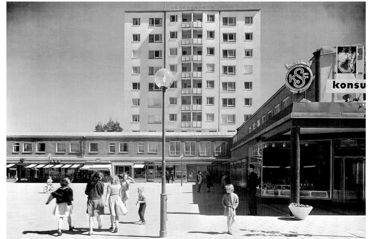
Nybyggda hus vid Lagaplan, Bagarmossens centrum. Punkthuset ritades av Nils Sterner. Foto Sunde Sundahl 1957. Källa: Digitalt museum.
