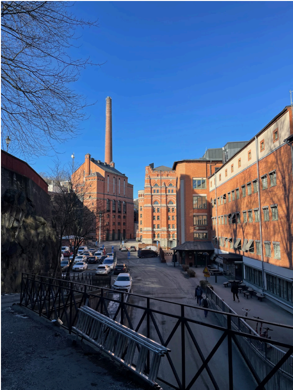
Gårdsrummets skala som ges av huskropparnas samspel med det omgivande berget. Spetsvärmeverket och Bryggeriets tornliknande fasad är huvudkaraktärer i rummet
