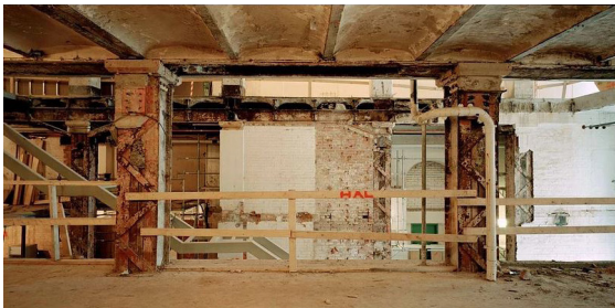
Trapphallen under tidigare renovering
