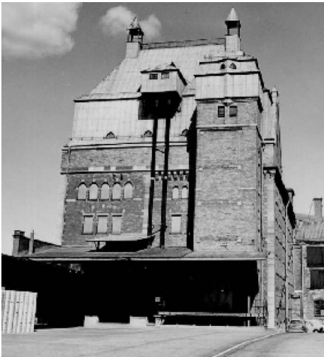
Bild från 1970-talet som visar hur tillbyggnaden såg ut innan den fick ett nytt entréparti och höga takfönster. Källa: SSM
