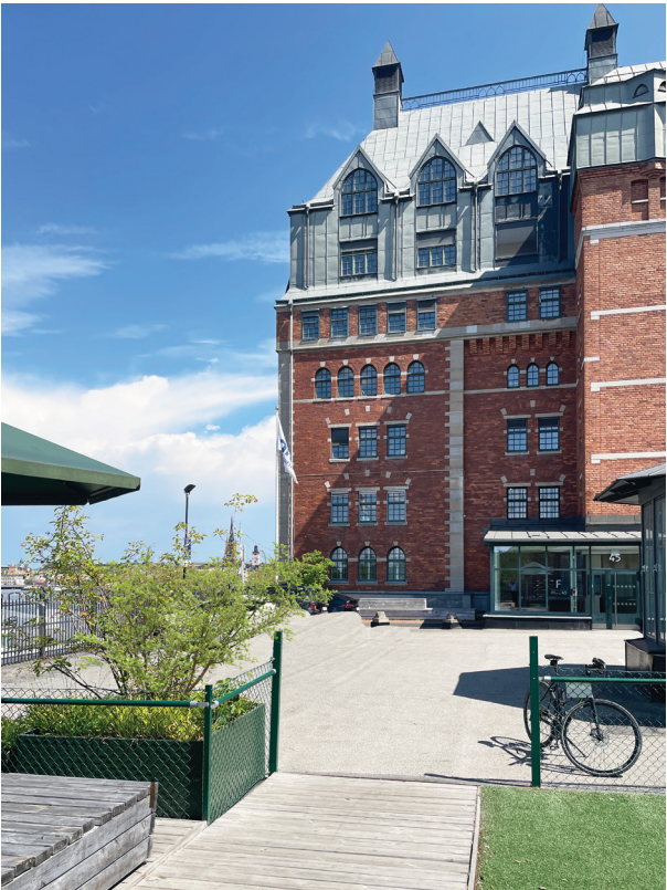
Münchenbryggeriets västra gavel med tillbyggt entréparti.
