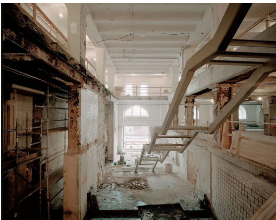
Trapphallen under tidigare renovering
