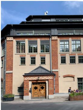
1892, fasadparti uppfört innan 1892
