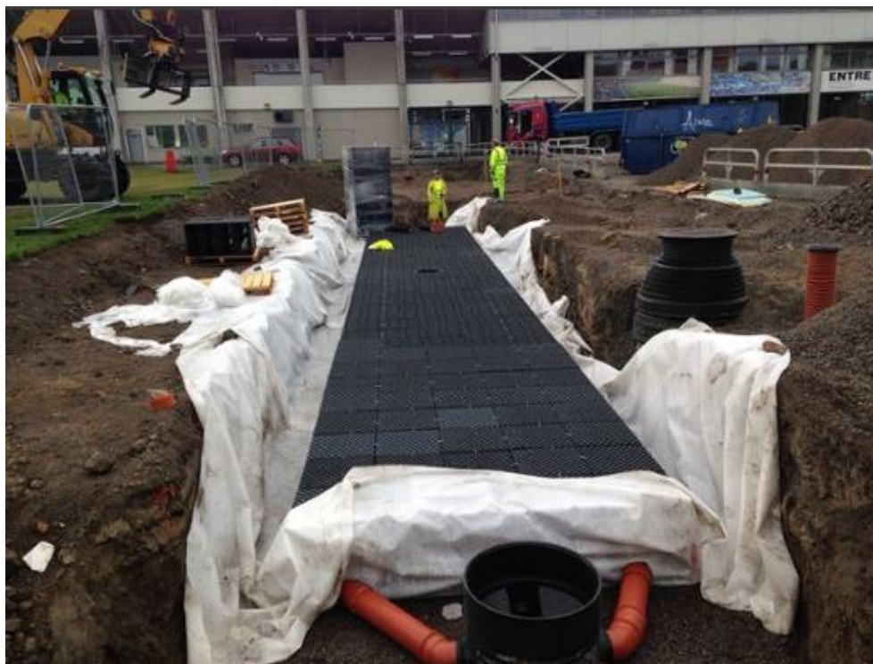
Figur 32 Perkolationsmagasin med kasettmagasin
