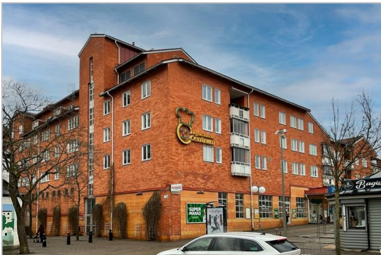
Kvarteret med centrumhuset från sent 1980-tal. Såväl arkitekturen som materialvalen är typiska för tiden och avviker på ett tydligt sätt från den omgivande 1950-talskaraktären.
