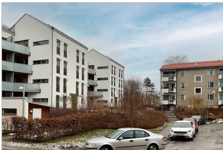
2010-talets tillägg ger uttryck för en mer självständig arkitektur i förhållandet till 1950-talets bebyggelse. Här på Emågatan.
