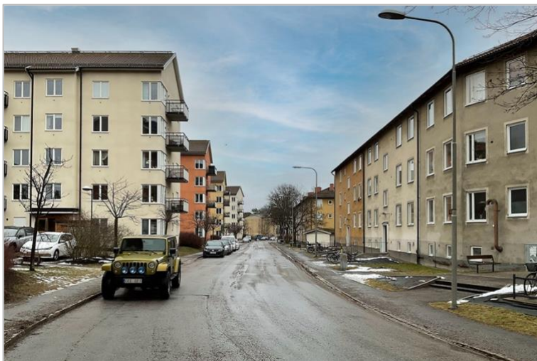
Fogdevägen med 1950-talsbebyggelsen till höger och det sena 2000-talets punkthus till vänster. Notera färgsättningen och fönstrens indelning och placering.
