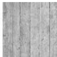
Betongsockel gjuten mot brädform.
