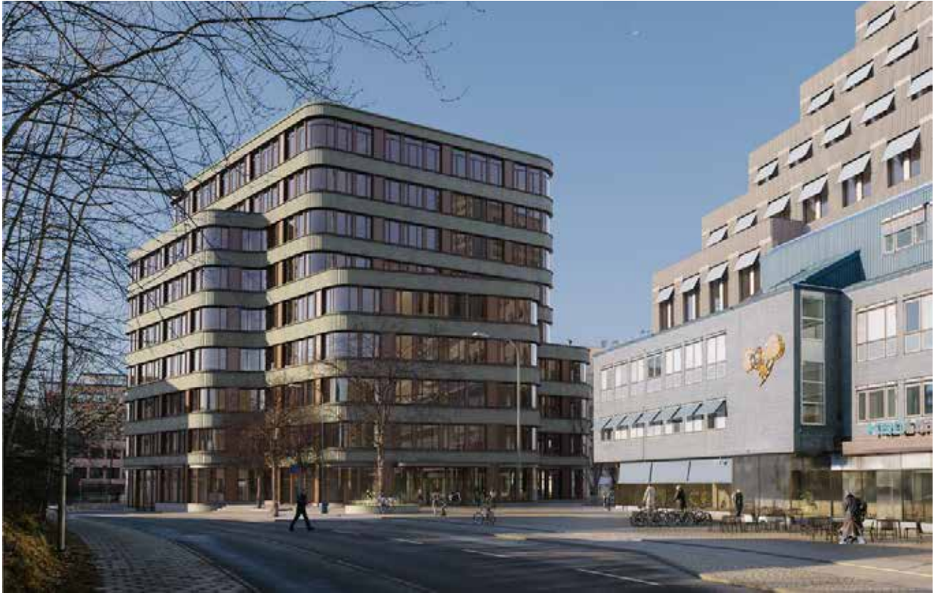
DN torget offentliga miljö stärks av Signalhusets och dess öppna bottenvåning,
