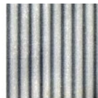
Betongsockel gjuten mot sinusform..
