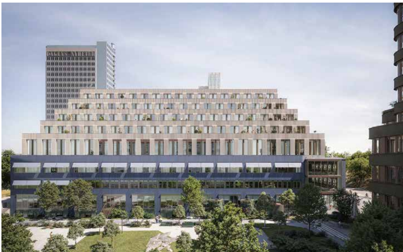
Vy från Signalparken mot öster. Till höger i bild syns burspråket mot den nya passagen, utfyllnadsvåningens inordnande fasaduttryck (översta blåa våningen) samt den successivt bakåttroppande påbyggnaden med dess olika terrasser.
