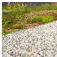
Sedum med inslag av lägre gräs och i kombination med grus där takytan ska beträdas.
