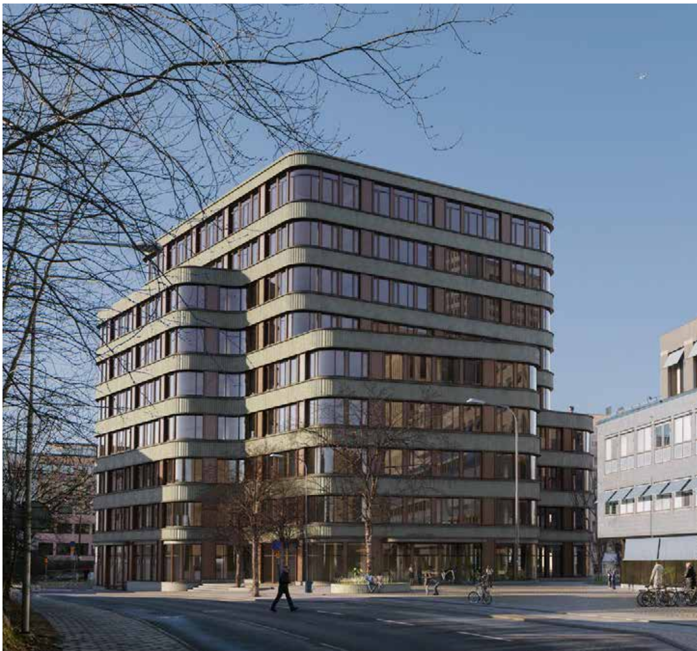
Fotomontage. Signalhuset som fond mot DN-torget. De svängda bröstningsbandens organiska rörelse skapar ett motiv som flätar samman de olika byggnadshöjderna till en helhet.
