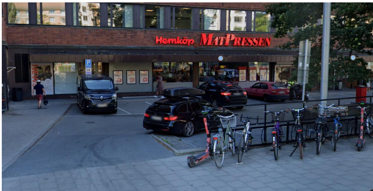
Figur 26 Parkeringsplatsen på norra sidan om TK 6. Entréer i marknivå med risk för skador vid översvämning
