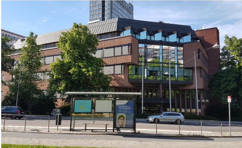
Figur 32 Kontorstillbyggnaden från 1990-talet.
