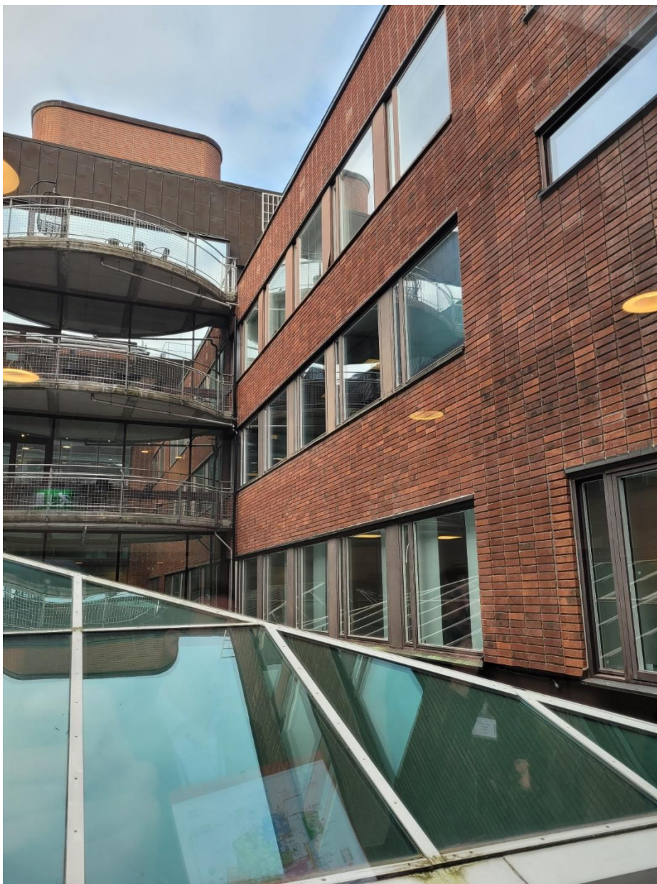
Figur 40 Till höger syns ursprunglig 1960-talsfasad som vetter mot ljusgården. Denna del föreslås motbyggas med det nya Ekenhuset.
