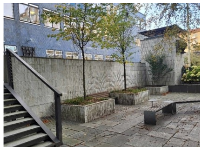
Inre mur med planteringskar och ventilationstorn. Skiffer i oregelbundet mönster på mark.
