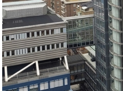
Månlandaren, stödben och räcken, fasadplåtar, fönsterband, glasad förbindelsegång till DN-skrapan och teknikutrymmen på tak.
