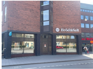
Burspråk och dörrparti i byggbrons vid gavel. Chamotteklädda pelare, listverk av koppar mellan.
