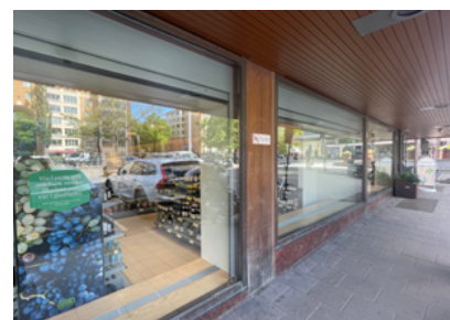
Fasad i butiksvåning uppdelad av vertikala fält av aluminium-panel.
