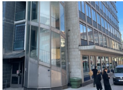
Utrymningstrapphusets nedre del. Fasad i glas och aluminium. Exponerad vitmålad skorsten och smidesräcke. Belysningslösning på trapploppets undersida.
