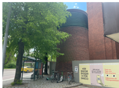
Ventilationstorn i tegel och kopparplåt.
