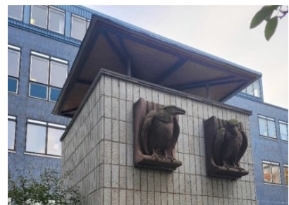
Ventilationstorn med Hugin och Munin, utförda i granit.
