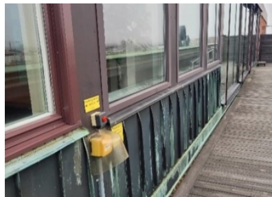
Representationsvåning med fasader av tegel, ursprunglig falsad kopparplåt och stora fönster (utbytta).
