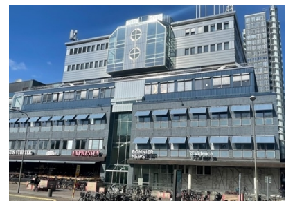
Uppglasat trapphus med ursprungliga aluminiumprofiler med tillägg i band-plåt. Trapphusets interiör: kalksten på trappor och golv, trappornas utformning, räcken och handledare.
