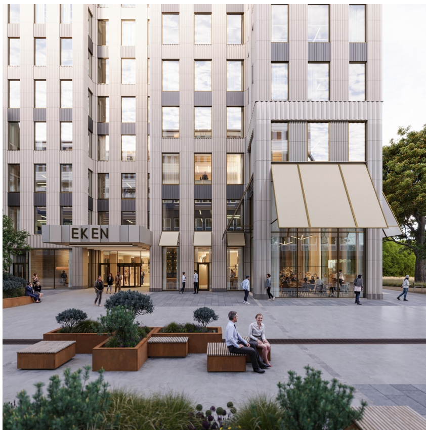
Fasad mot Lastgatan med markerad bottenvåning med annan materialbearbetning, fast solavskärmning och dubbelhög lokal (Wingårdhs).
