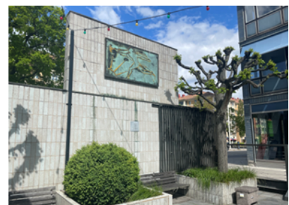
Insida mur mot Rålambsvägen, skjutbar smidesgrind, planteringskar i chamotte med bänkar spända mellan.
