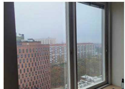
Fönstrens insida, karmar och bågar av trä, tidstypisk profilering och ursprungliga glas. Fönsterbänkar
