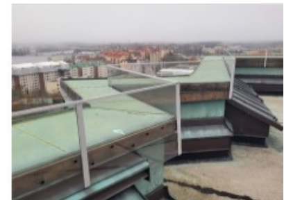
Takfot/taksarg i koppar vid takterrass.
