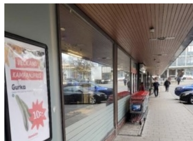
Butiksvåning. Skärmtak viktig för karaktären. Sockel i polerad granit, ursprungliga fönsterpartier i byggbrons.
