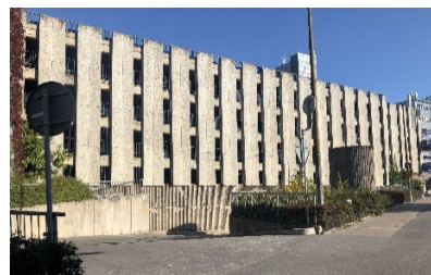
Parkeringshusets fasad inom Trängkåren 7 mot Gjörwellsgatan med ramper och slutna fasader.
