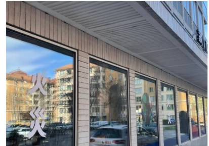
Skärmtak med utmed bottenvåning med mönstergjuten under-sida i vit betong.
