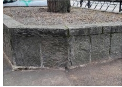
Naturstensmur vid ek.
