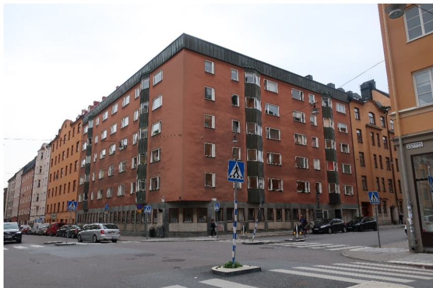
Byggnaden på fastigheten Harven 3.
