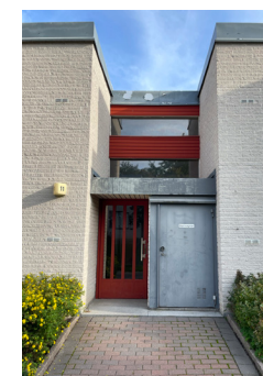
Entréparti till bostadshus, där i princip alla byggnadsdetaljer utom kalksandstenen bytts.
