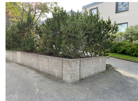
Planteringsmur i betong med frilagd sjösten.
