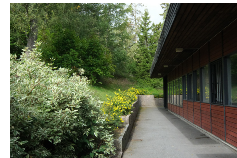
Servicehuset har bevarade träpartier. Motsvarande partier på bostadshusen har bytts mot plåt.
