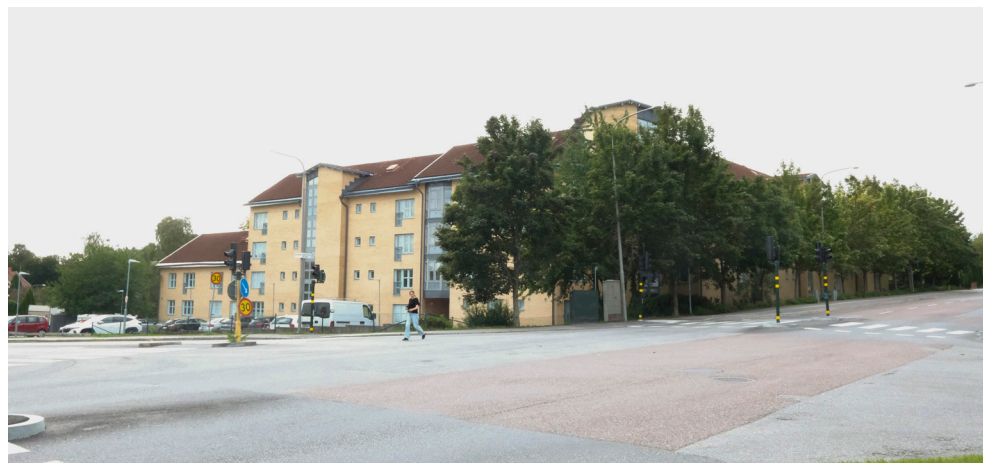
Kv Helge, uppfört 1995-96 från nordväst.
