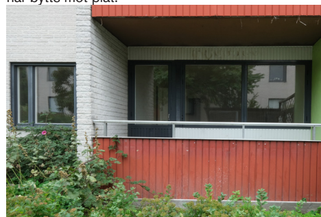
Balkongdörr och fönsterpartier mot balkongen är ursprungliga i trä. Det plåtklädda fönstret i fasaden till vänster är sekundärt tillkommet, liksom balkongfronten med räcke.
