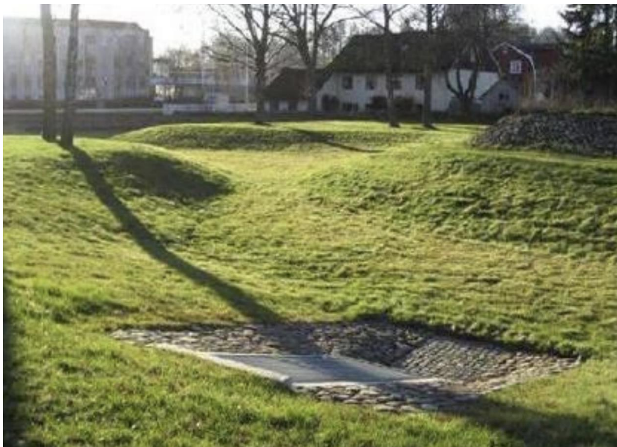
Figur 19. Skålad grönyta där dagvatten kan fördröjas och infiltrera. Bild: Härnäs kommun dagvattenstrategi, 2011.
