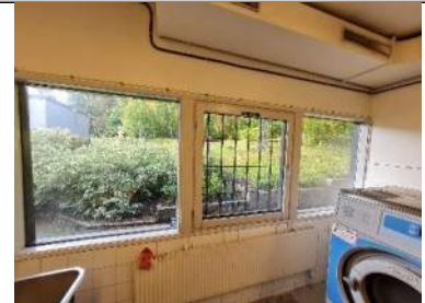
Bild 25. Nyare och äldre isolerrutor.
