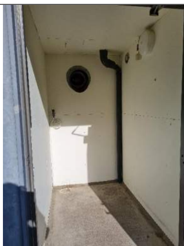
Bild 16. Samtliga barnvagnsrum, eternitklädda väggar och tak.
