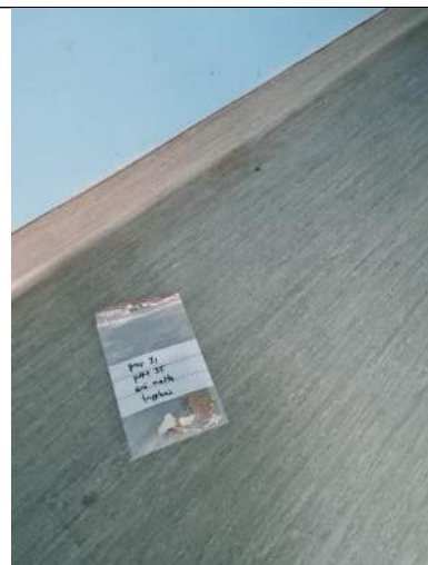
Prov 31. Grå matta+lim+papp, trapphus. Asbest ej påvisat i analys, men innehåller troligen asbest. Se prov 45.
