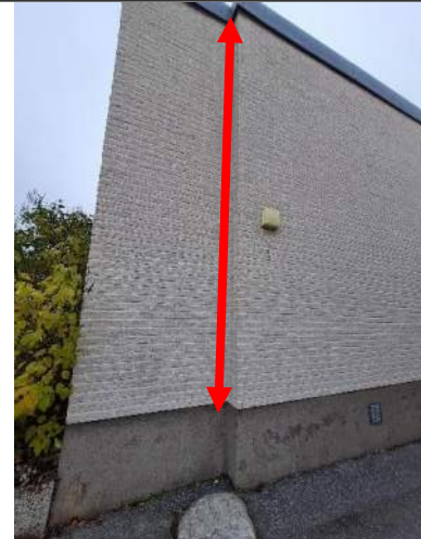
Bild 22. Typbild fasad, ljusgrå fogmassa lagd i sprickor. Innehåller ej klorparaffiner.
