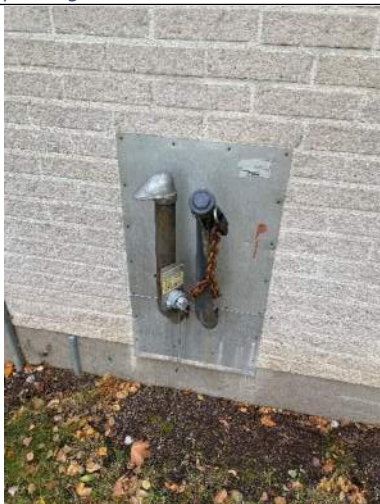
Bild 41. Påfyllningsrör till oljetank i G2, oklart om oljetanken finns kvar.
