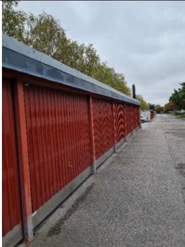
Bild 35. Översiktsbild garage G1.
