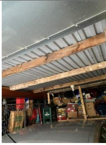
Bild 36. Inv. garage. Belamrat och ej möjligt att undersöka närmare. Inga miljölaster synliga.
