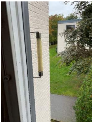
Bild 7. Äldre termometer, kan innehålla kvicksilver.
