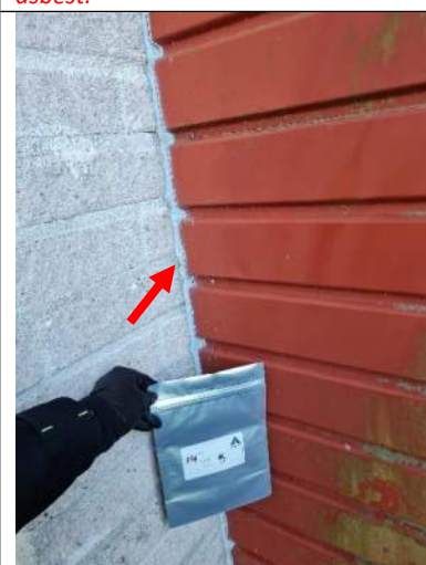
Prov 41. Ljusgrå fogmassa (samma provställe som prov 50) innehåller klorparaffiner.
