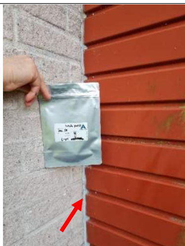
Prov 50. Ljusgrå fogmassa innehåller klorparaffiner. Samma provställe som prov 41.
