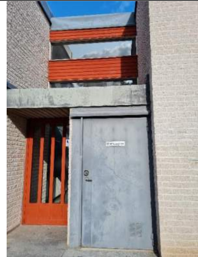
Bild 19. Översiktsbild entré. Äldre branddörr, de flesta är utbytta till barnvagnsrummen.
