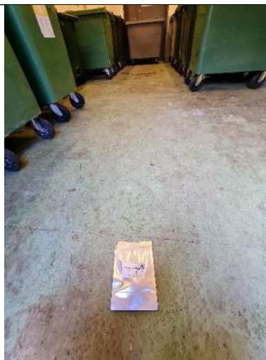
Prov 21. Grön golvbeläggning, miljöstuga.
