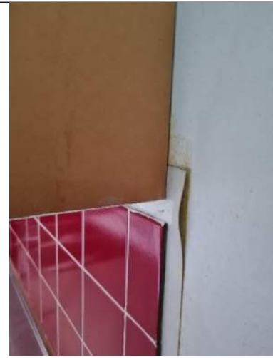
Bild 6. Plastmatta bakom kakel, innehåller asbest, finns troligen i majoriteten av kök.
