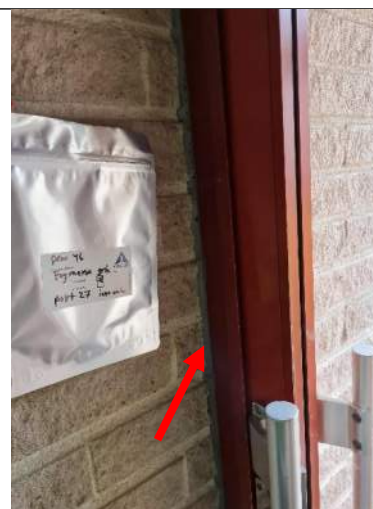
Prov 46. Grå fogmassa, entré inv+utv. innehåller klorparaffiner.
