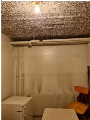
Bild 51. G3. Äldre rörböjar och rörändar med asbestinnehåll.
