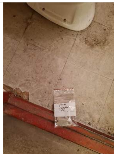
Prov 40. Vinylplatta+lim källar-WC.
