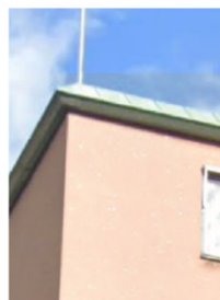
Tydlig och karaktäristisk takfot i oxiderad koppar.
