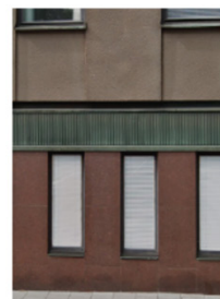
Sockelväning i släthuggen, polerad natursten. Horisontellt listverk av koppar.
