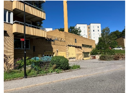
Befintlig sopsugstation och värmecentral inom Stapelbädden 8.
