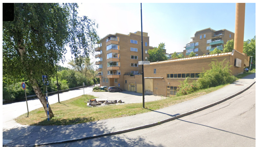
Stapelbädden 8. Byggnad med panncentral och sopsugsanläggning med last- och vändzon framför.
