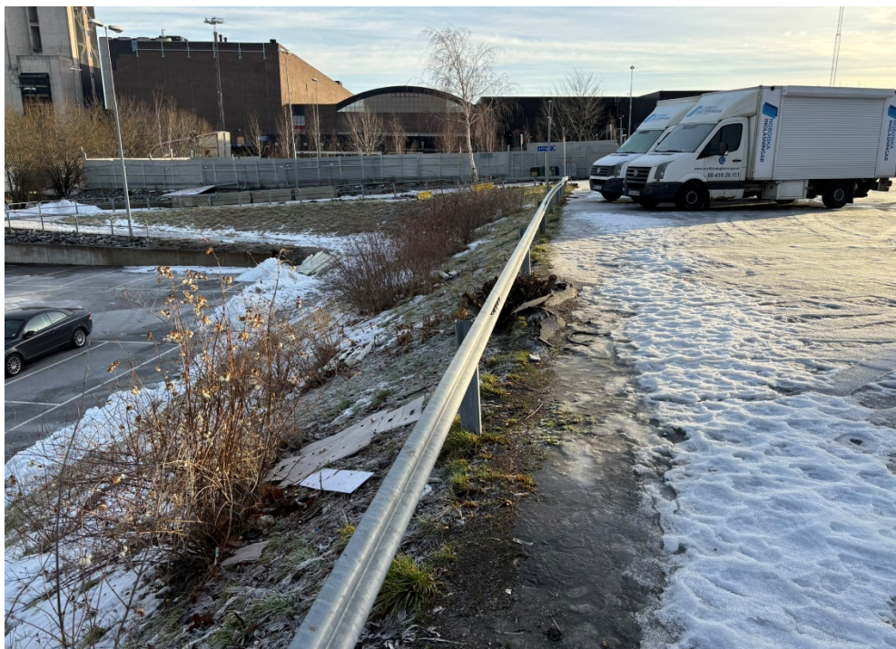
Figur 4. Foto på slänt i norra delen av fastigheten. Vy mot sydöst/söder. Foto taget 2025-01-15.
