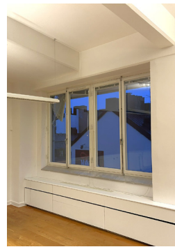
Ursprungliga kopplade, ospröjsade 1930-talsfönster med spanjolett, putsad fönsternisch och vinklad marmorbänkskiva.
