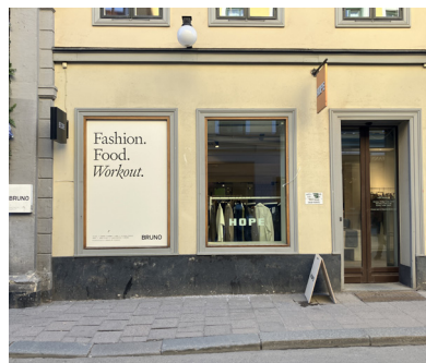
Butiksfönster och butiksdörr från 2000-talet med profilerad dörrumfattning.
