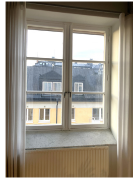
Ursprungliga höga kopp-lade 1920-talsfönster i de ursprungliga bagerilokalerna på vän 2 & 3 tr, med spanjoletter, spröjs i de yttre bågarna, helglasad ruta i de inre bågarna, vinklad marmorbänkskiva och djupa, putsade fönsternischer med glaserat tegel i den nedre delen.
