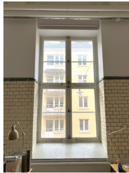
Bevarat ursprungligt trapphus från 1920-talet med hög bröstning i kakel som följer med in i fönstersmygarna. Handledare i svart smide, vilplan och trappsteg i kalksten. Glasade pardörrar i ek. Kopplade, spröjsade fönster med spanjolett, fönsterbänk i kalksten. Industrihiss och våningsplansdörrar i stål.
