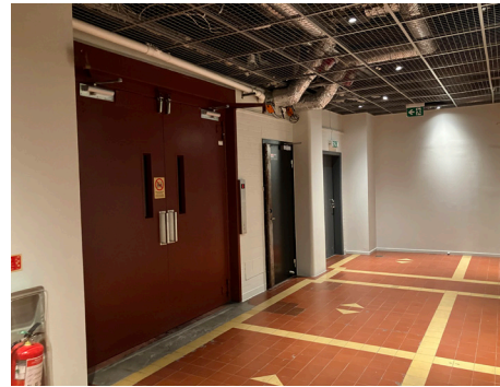
Industrihiss med ståldörrar, 1930-talstillbyggnaden.
