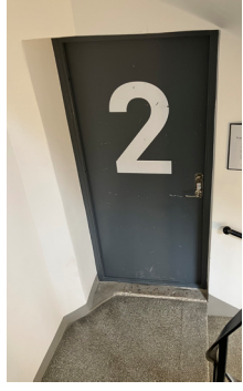
Bevarat ursprungligt trapphus från 1930-talet med vilplan och plansteg i terrazzo, handledare i svart smide, wc-dörrar i ek och våningsplandörrar i stål.
