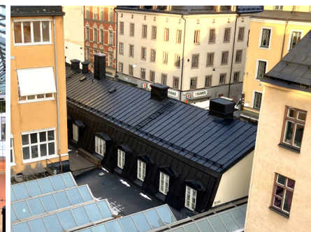
Bevarat ursprungligt mansardtak från 1830-talet mot gården med takkupor från olika perioder med senare utförd enhetlig plåtinklädnad från 2000-talet. Bottenvåningens fasad, som är helt ombyggd och integrerad i gallerian, döljs av en tillbyggnad från 1920-talet samt senare tillkommet gårdsbjälklag.
