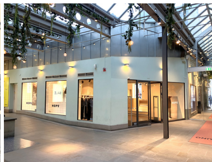
Butikslokaler mot galleriatorget med fönster och entré från 2000-talet i en på 1920-talet uppförd gårdstillbyggnad av huvudbyggnaden.
