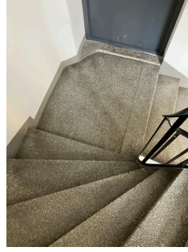
Bevarat ursprungligt trapphus från 1930-talet med vilplan och plansteg i terrazzo, handledare i svart smide, wc-dörrar i ek och våningsplandörrar i stål.
