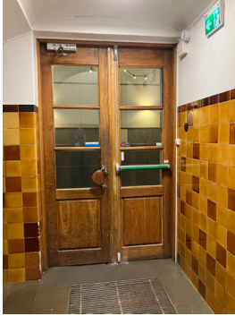
Bevarat ursprungligt trapphus från 1920-talet med hög bröstning i kakel som följer med in i fönstersmygarna. Handledare i svart smide, vilplan och trappsteg i kalksten. Glasade pardörrar i ek. Kopplade, spröjsade fönster med spanjolett, fönsterbänk i kalksten. Industrihiss och våningsplansdörrar i stål.
