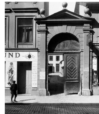
Foto 1885. Till höger skymtar hus 1 spröjsade fönster, till vänster hus 2 ursprungliga fönster med tvärpost och tre luffer.
