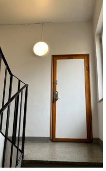
Bevarat ursprungligt trapphus från 1930-talet med vilplan och plansteg i terrazzo, handledare i svart smide, wc-dörrar i ek och våningsplandörrar i stål.
