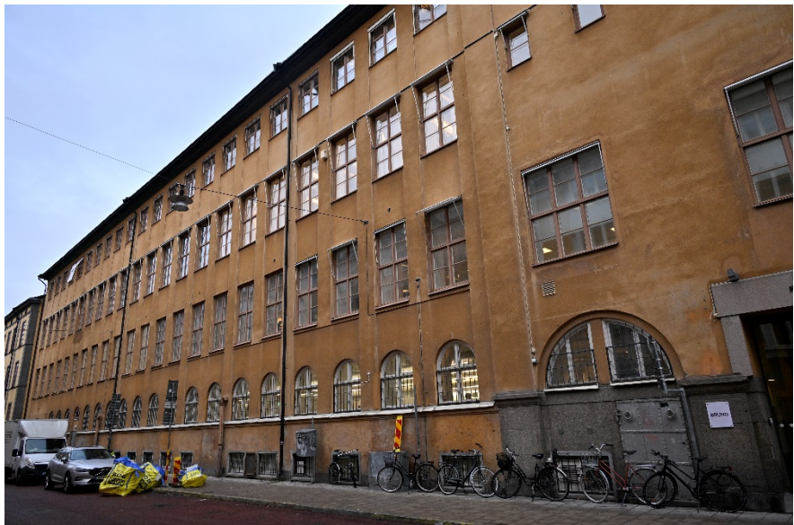
Byggnaden mot Repslagatgatan. Foto: SBK
