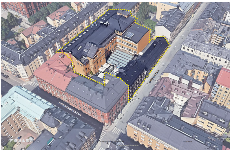
Figur 3. Snedbild mot nordväst, fastigheten Västergötland 21 markerad med streckad gul linje
