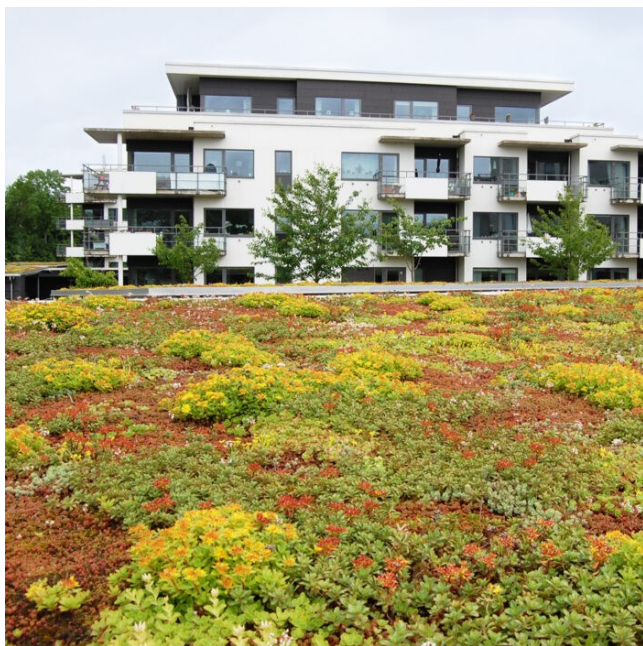
Figur 11 Principförslag, Sedumtak, VegTech
