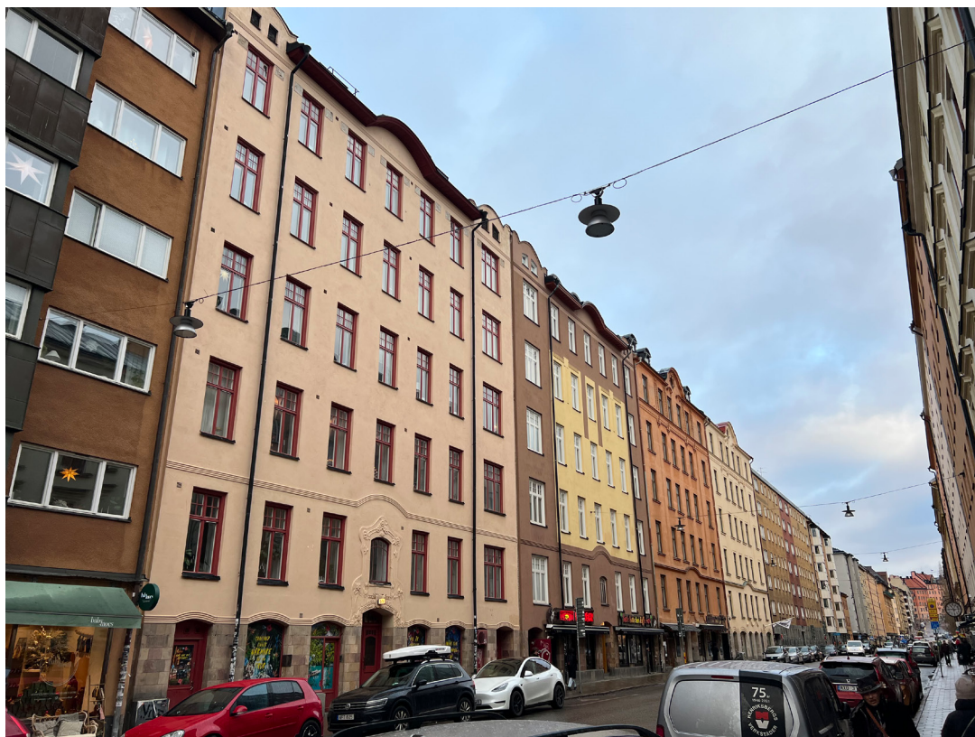
Vy längs Skånegatan mot öster med fyra stycken hus på rad från början av 1900-talet ritade av arkitekterna Dorph & Höög.
