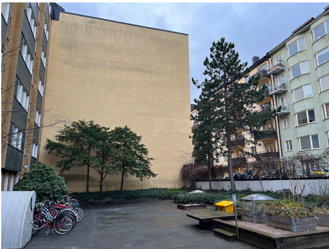
Gården mot väster med cykelförråd, träd och sandlåda. Till höger syns lanterniner.
