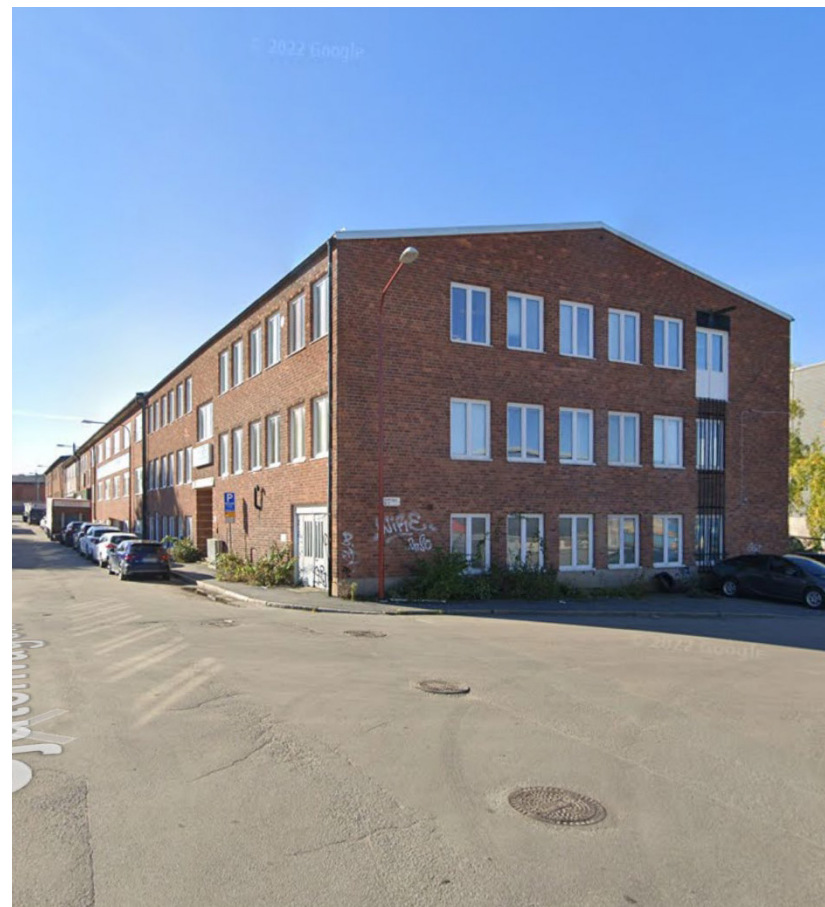
Valsverket 7, sett från Gjuterivägen i oktober 2022. Källa: Google Maps.
