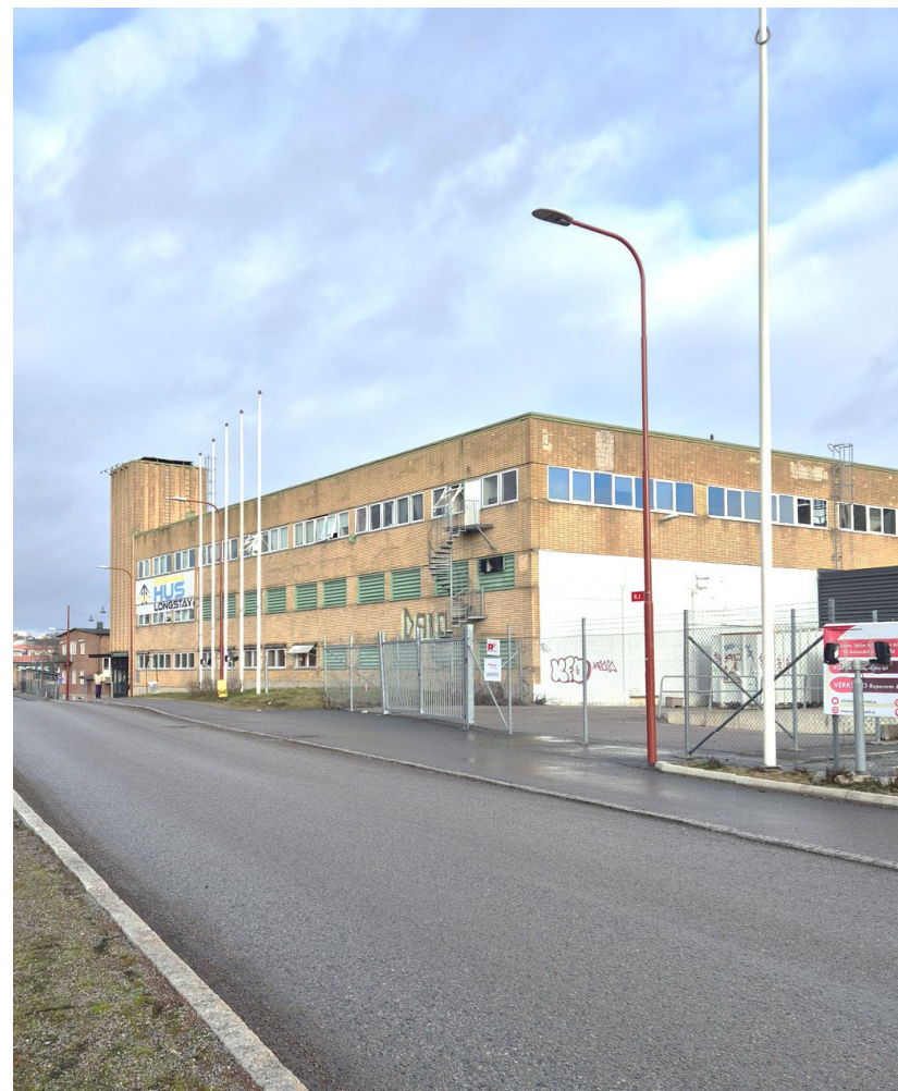
Gjutmästaren 5, sedd från Masugnsvägen i februari 2025.
