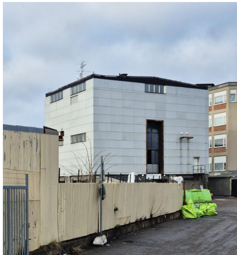
Baksidan av Tackjärnet 3, sett från Råjärnsvägen i februari 2025.
