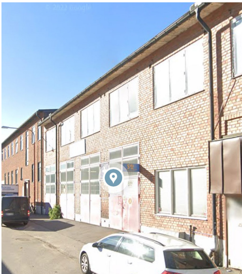
Valsverket 8, sett från Gjuterivägen i oktober 2022. Källa: Google Maps.
