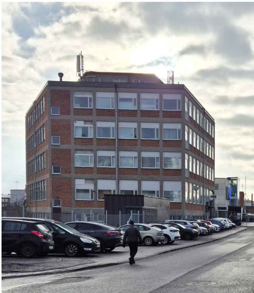
Industri- och kontorsbyggnadens på Tackjärnet 4 i februari 2025.
