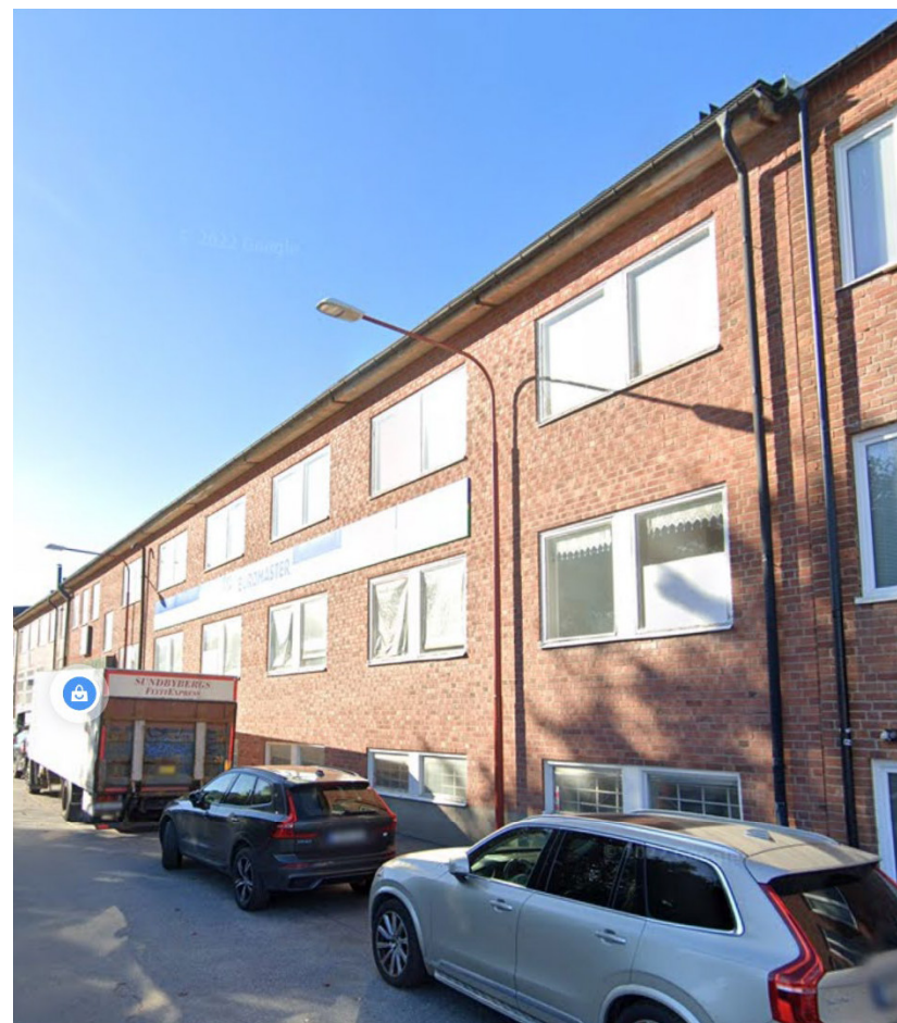
Valsverket 9, sett från Gjuterivägen i oktober 2022. Källa: Google Maps.
