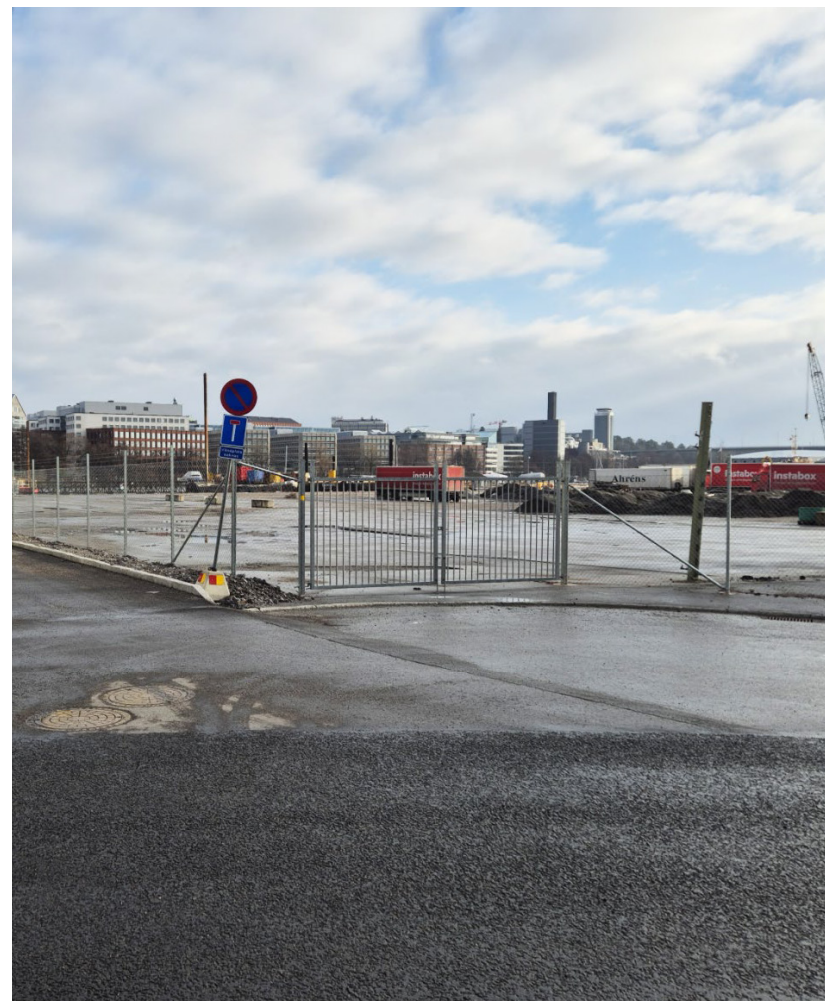
Den avrivna tomten på Masugnen 1 i februari 2025, sedd från väster i det hörn där Masugnsvägen och Råjärnsvägen möts.
