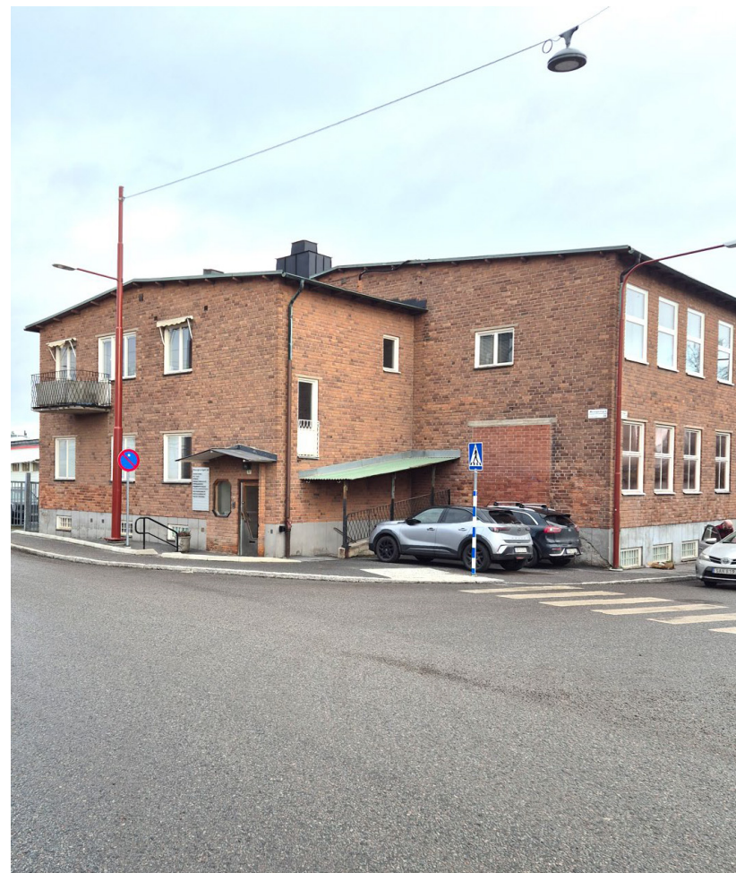
Valsverket 5, sett från korsningen Masugnsvägen-Gjuterivägen i februari 2025.
