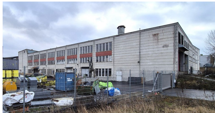
Gjutmästaren 4, sedd från Gjuterivägen med Bällstaviken i ryggen, i februari 2025.
