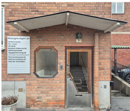
Entrén till byggnadens kontorsdel.
