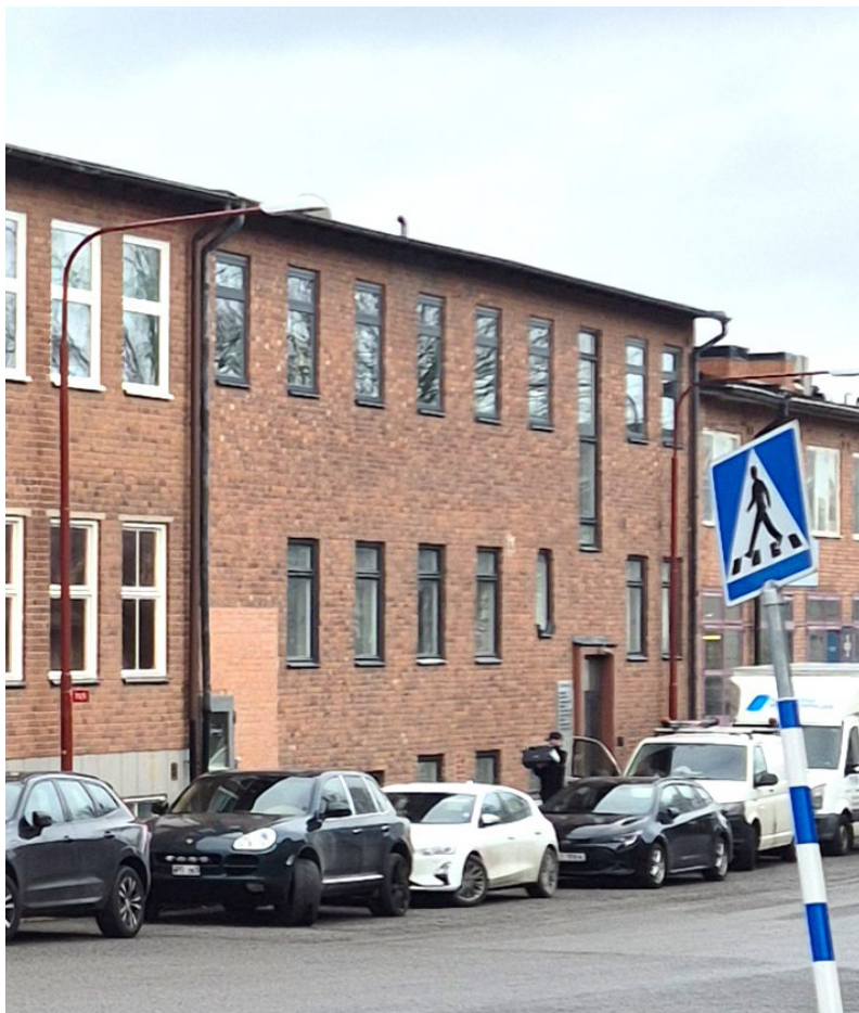
Valsverket 6, sett från Gjuterivägen i februari 2025.
