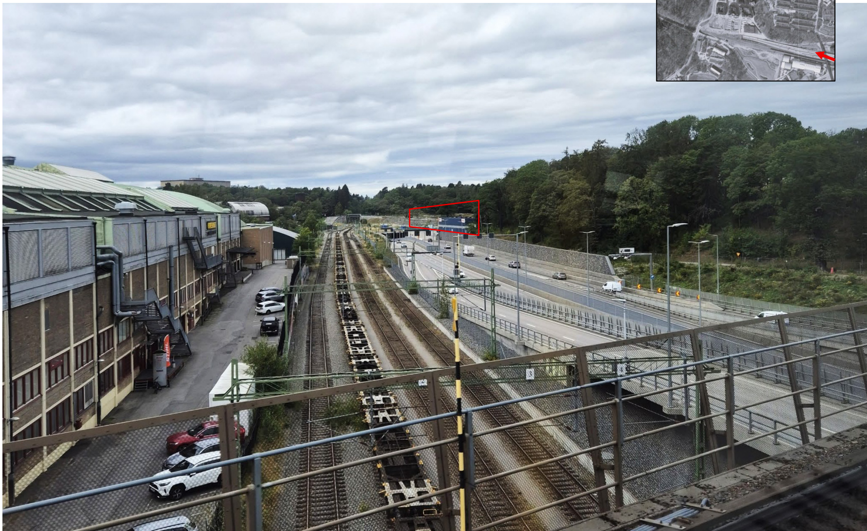
Samma vy som på föregående sida, mot väster, men från tunnelbanebron, med planområdet snett till höger i bild. Källa: Google Maps.
