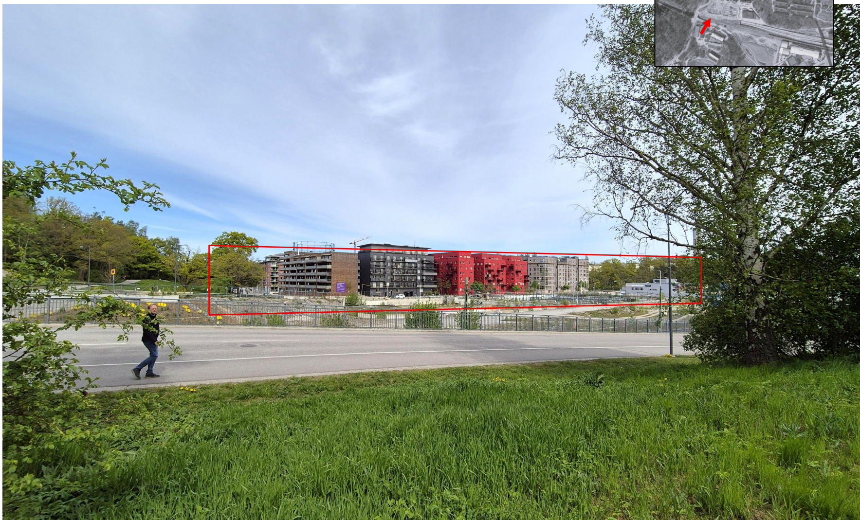
Vy mot planområdet, sett från söder, strax intill Bobergsbron. I fonden ligger Norra Djurgårdsstadens nuvarande front, bestående av kvarteren Färnebofjärden, Muddus och Kosterhavet. Den grå, envåninga byggnaden längst till höger är den livsmedelsbutik som redan idag finns på fastigheten Ängsbotten 8 och 9.
