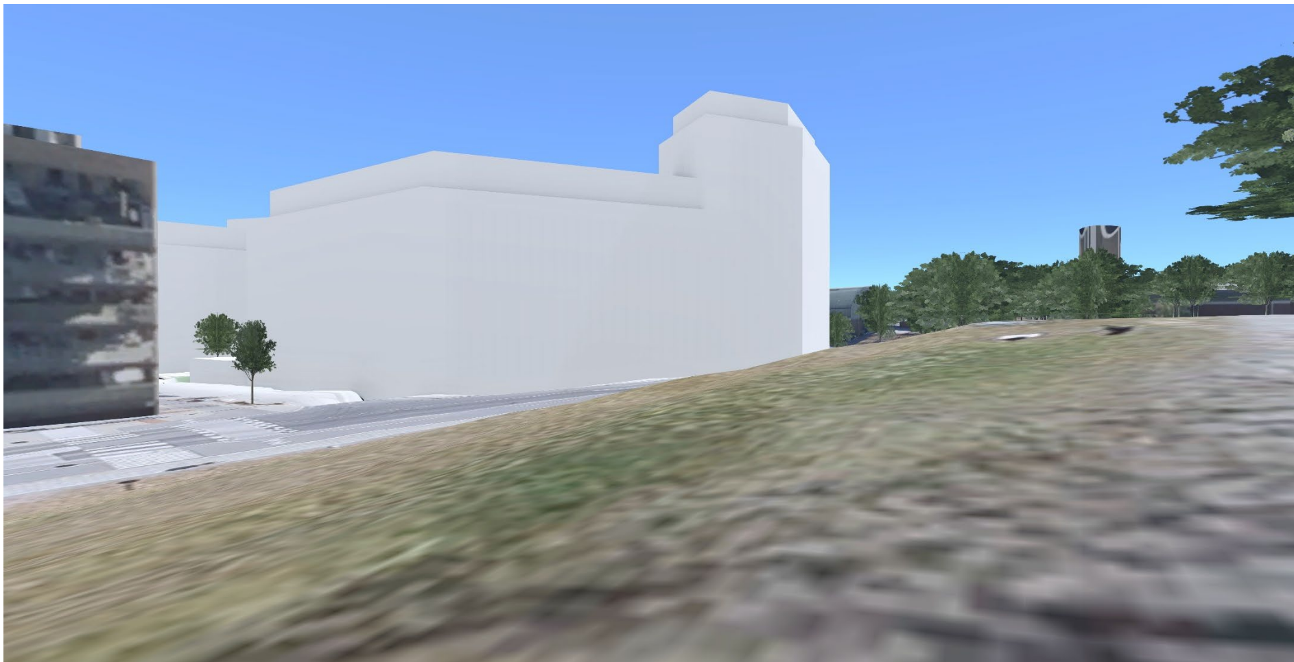
Vy mot planområdet, sett från Ugglebacken i nordväst. Längst till vänster ses kvarteret Färnebofjärden och längst till höger Norra länkens ventilationstorn. Jämför med foto på sidan 8. Källa: https://eu.opencitiesplanner.bentley.com/stockholm/angsbotten653214
