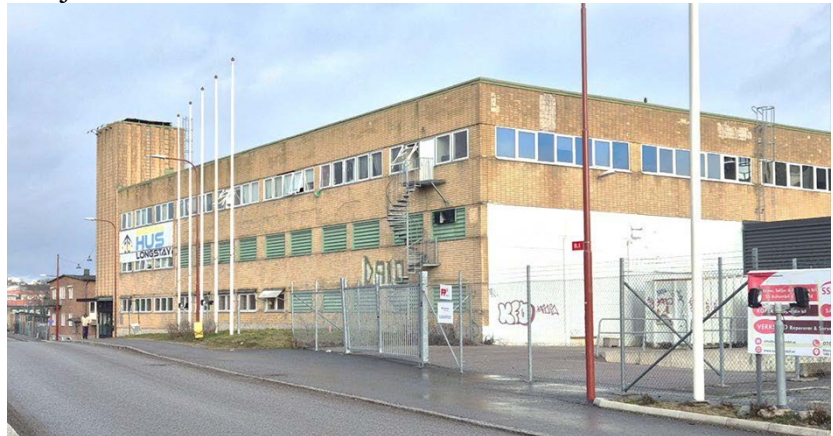
Gjutmästaren 5, vy från Masugnsvägen.
