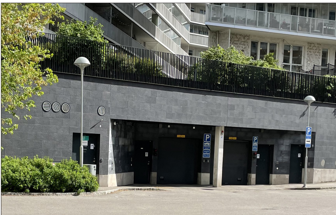
Figur 6 In- och utfart till garage för Rosteriet 7 samt miljörum för förskolan vid port till vänster i bild.
