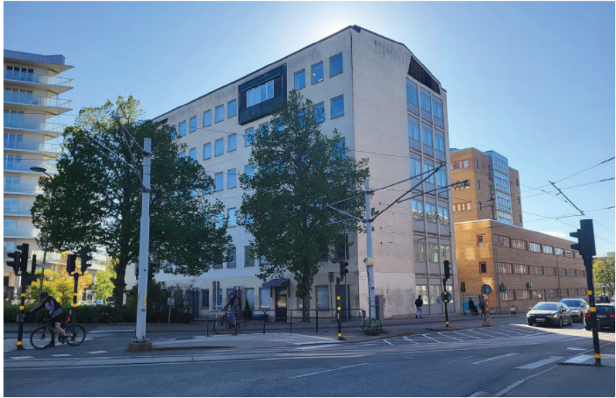
Hus A. Vy från korsningen Liljeholmsvägen-Lövholmsvägen.
