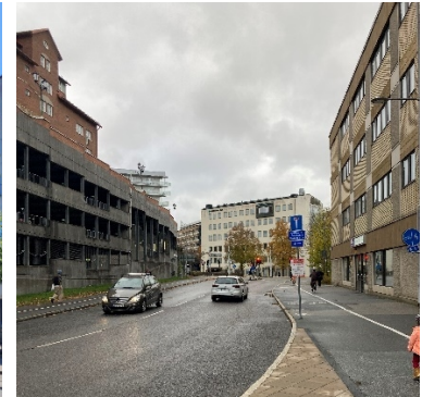
Liljeholmsvägen med parkeringshus inom Lilla Katrineberg 3 till vänster och kontorsfastighet inom Stora Katrineberg 8 till höger.
