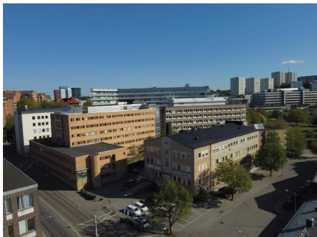
Flygvy från nordväst, med Rosteriet 5 närmast i bild till höger, kontorshuset B-C-D i kvarterets mitt, och det vita putsade hus A längst bort till vänster. Bakom kontorshuset reser sig det högre flerbostadshuset inom Rosteriet 7.
