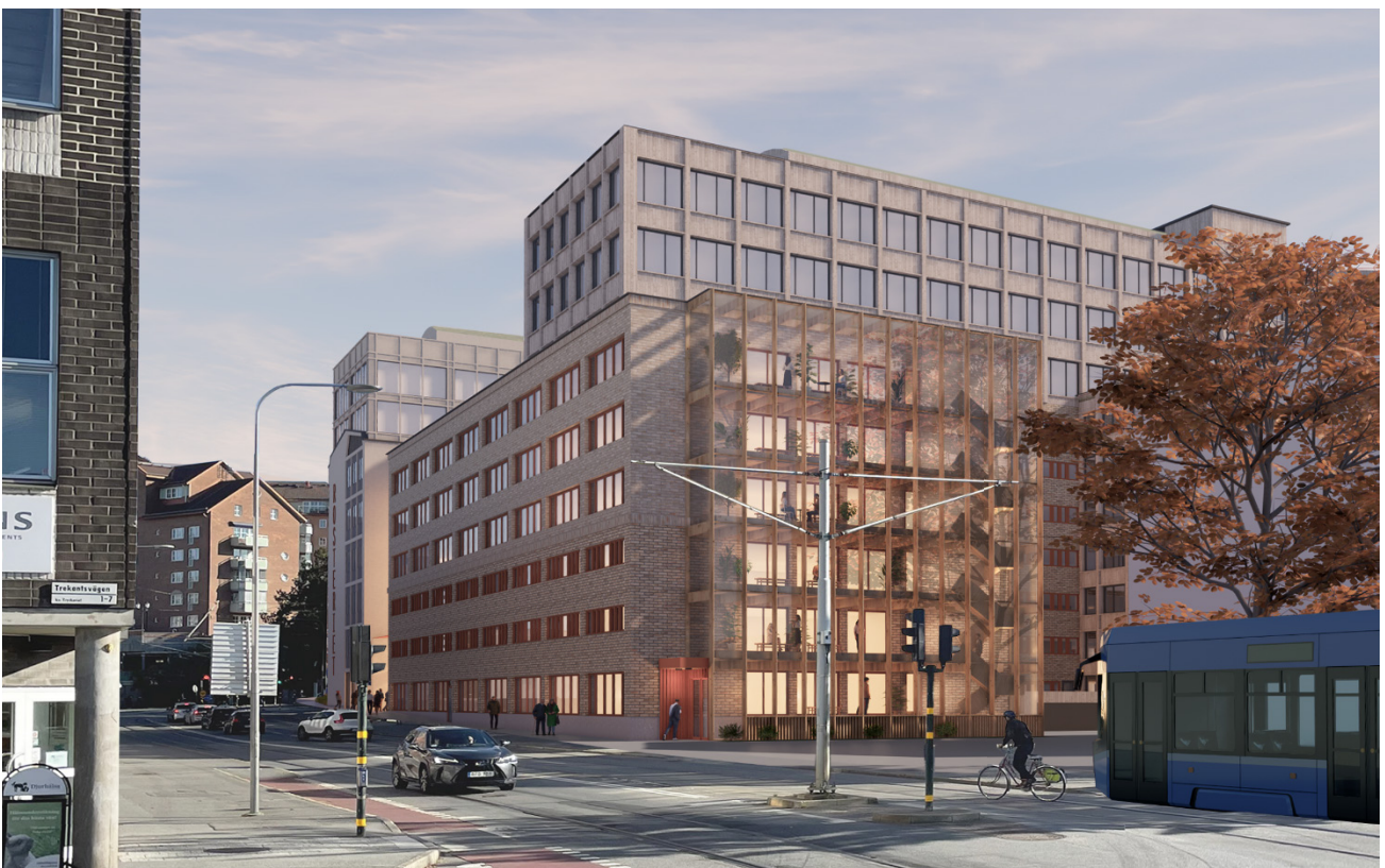
Vy från Lövholmsvägen, sett från nordväst. Fönster i bottenvåningen får en lägre bröstning. Gaveln på hus B föreslås förlängas för att möjliggöra en ny entré mot Lövholmsvägen. Illustrationen visar exempel på möjlig gestaltning. (Illustration Strategisk Arkitektur).
