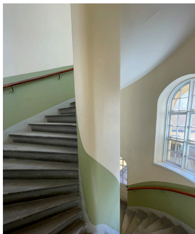
Trapphuset med trappspindel, handledare och fönster som kommer att rivs.
