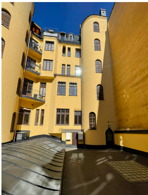
Taklanterninerna idag. Till vänster den inbyggda lanterninen. Till höger lanterninen i glasbetong som ger dagsljus till lilla salen.
