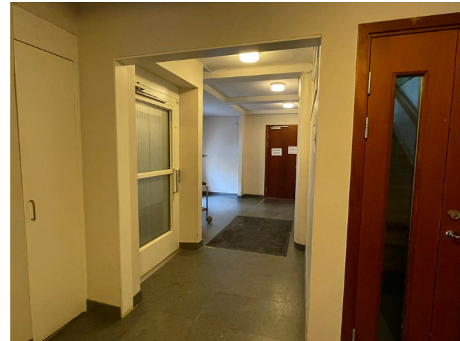
Vestibulen som tillkom 1936 och hissen från den senaste ombyggnationen.
