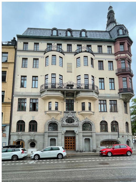
Fasaden mot Västmannagatan.
