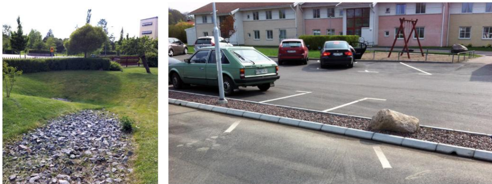
Figur 20. Två exempel på makadamdiken. Diket till vänster har en enkel utformning och tar emot vatten från väg och översilningsyta. Diket till höger avleder dagvatten från en parkeringsyta. Dagvattnet rinner in i diket via hål i kantstenen (Stockholm Vatten och Avfall, 2025b). Höjsättningen av parkeringsytan mot makadamdiket är avgörande för välfungerande rening.
