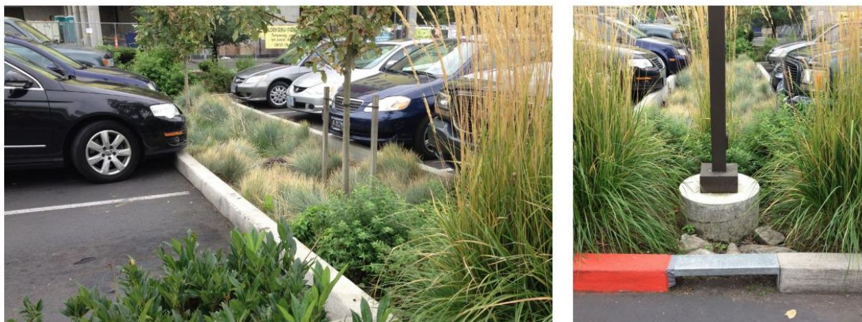
Figur 17. Exempel på nedsänkta växtbäddar (Stockholm Vatten och Avfall, 2025).
