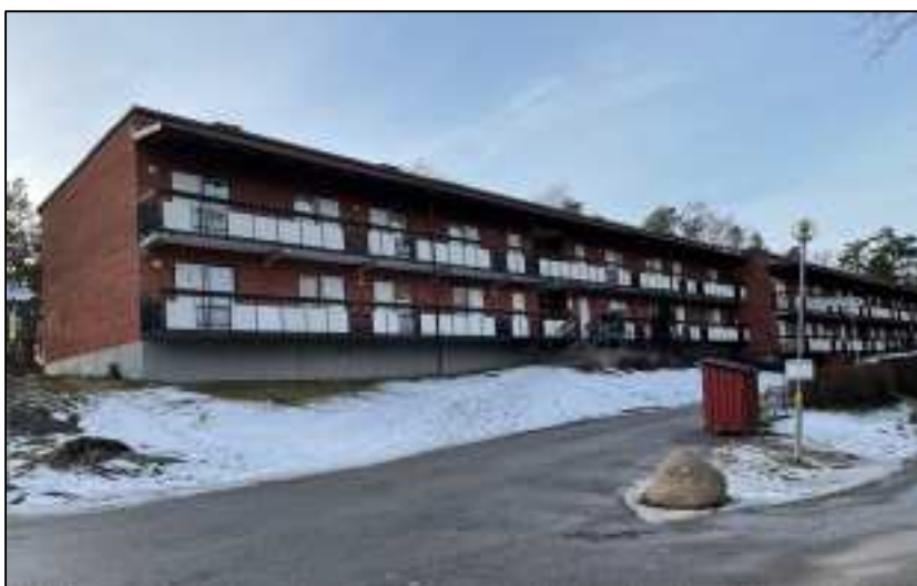
Figur 3. Befintligt hus som ska rivas.
