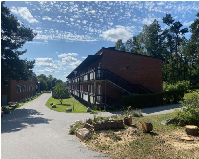
Vy över befintligt loftgångshus från den norra sidan.
