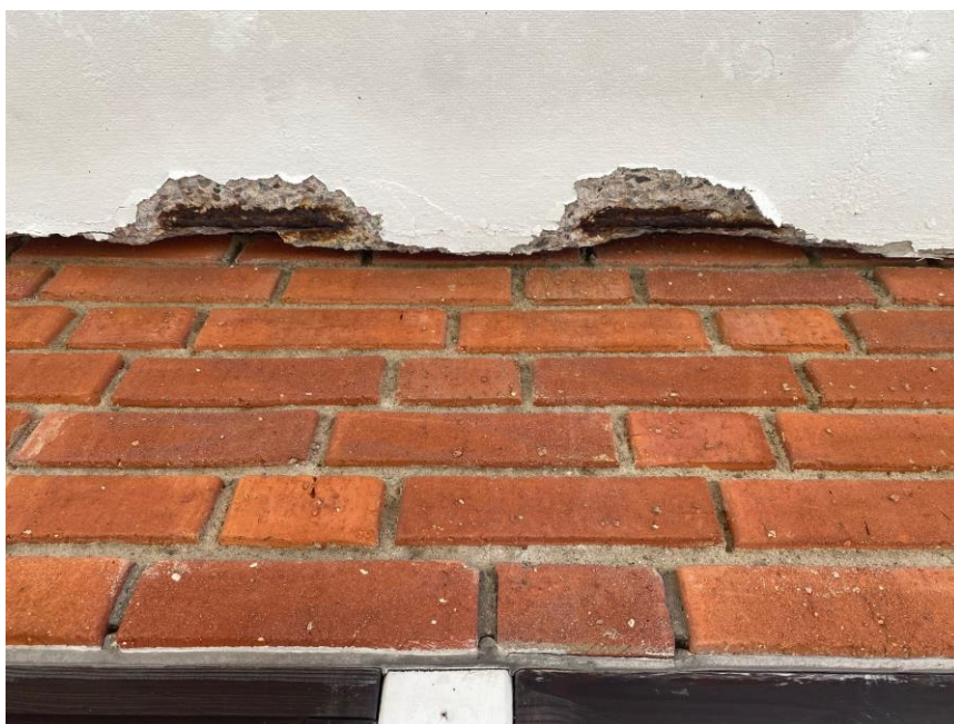
Vy över undersida av undertak i övre loftgång med synliga armeringsjärn.
