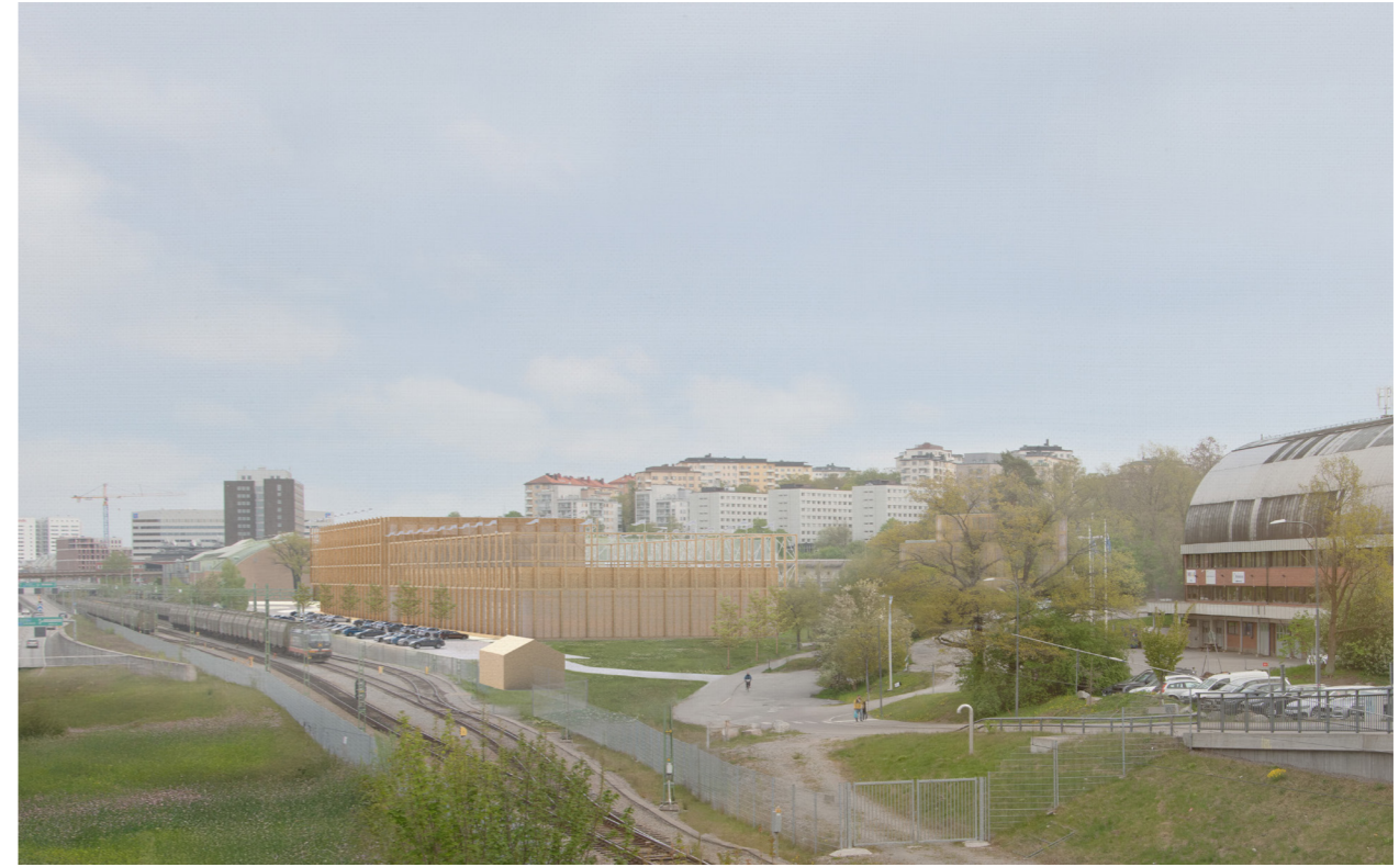
5. VYPUNKT 5 – Bobergsbron mot sydost
