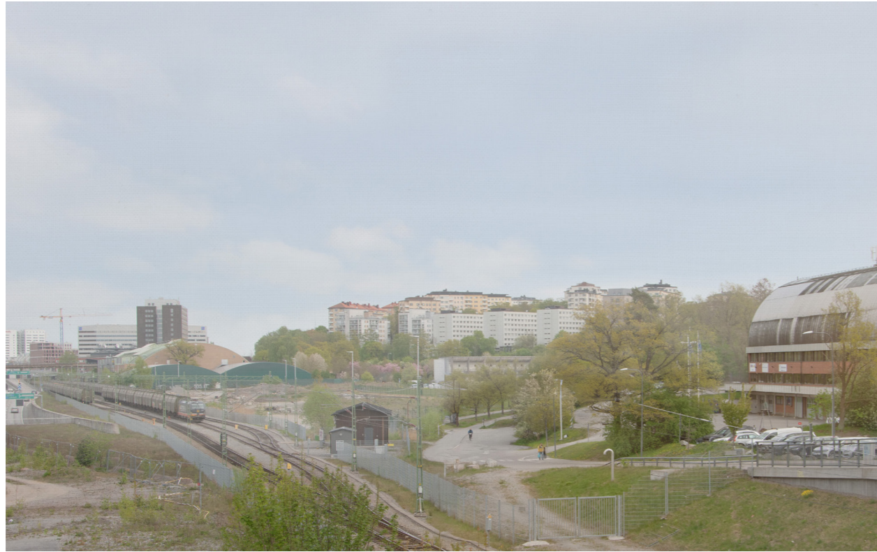
5. VYPUNKT 5 – Bobergsbron mot sydost
